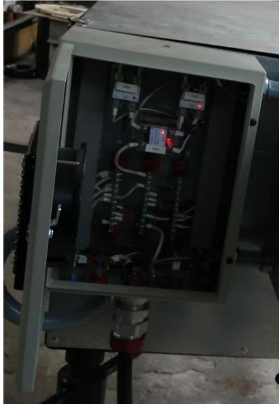
**Ilustración 4-8:** Comprobación del funcionamiento del tablero de potencia
