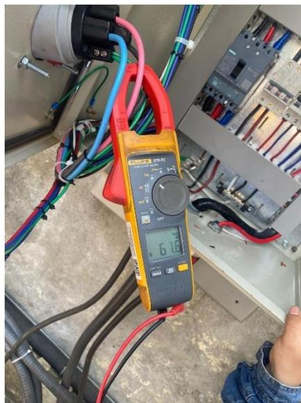
**Ilustración 4-9:** Toma de datos reales de corriente
