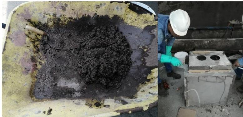
**Ilustración 3-40:** Preparación del concreto y fundición de las paredes de la cámara de calor
