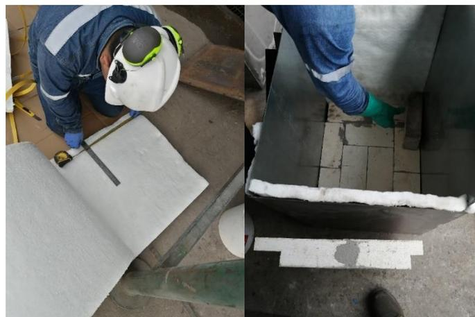
**Ilustración 3-39:** Colocación de la fibra y construcción de las paredes.
