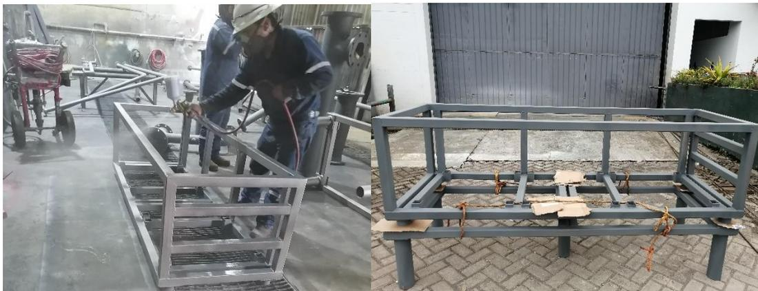
**Ilustración 3-35:** Granallado y aplicación de pintura base a la estructura del horno
