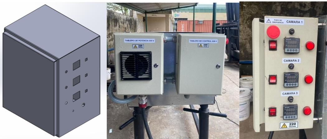
**Ilustración 4-5:** Tableros eléctricos, diseño vs real
