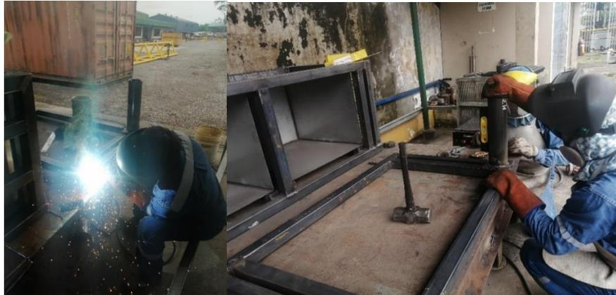
**Ilustración 3-32:** Colocación de los parantes en la base de la estructura
