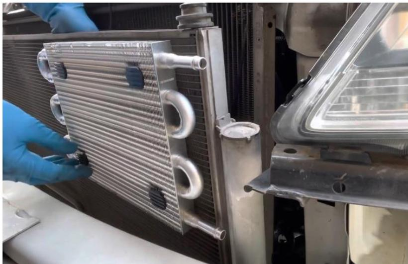
**Figura 8-4.** Instalación del radiador convencional
