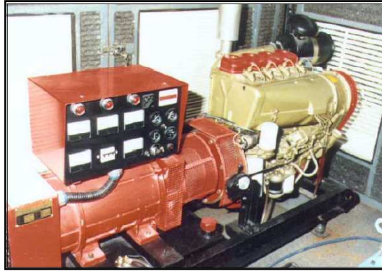
Figura 78. Grupo electrógeno a diesel de la subestación eléctrica.
