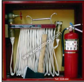
Figura 80. Gabinete de seguridad para la extinción de incendios.
