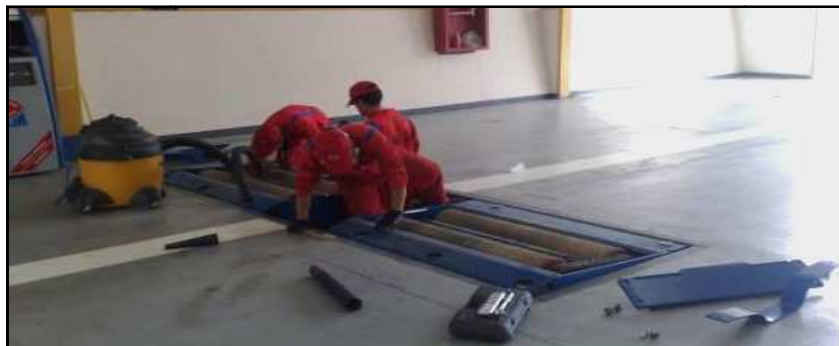
Figura 88. Trabajos de mantenimiento preventivo.
