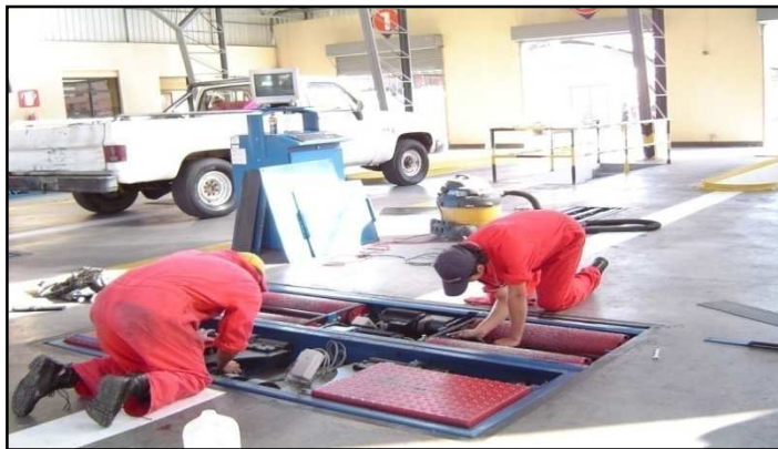
Figura 89. Trabajos de mantenimiento correctivo.
