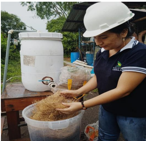
Acondicionamiento del biofiltro
