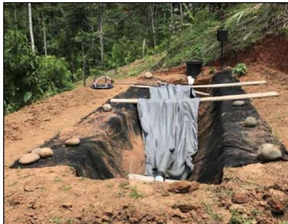
**Ilustración 4-11:** Colocación del geotextil y geomembrana
