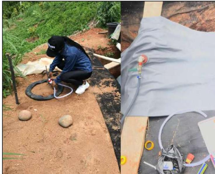
**Ilustración 3-5:** Conexión salida del biogás
