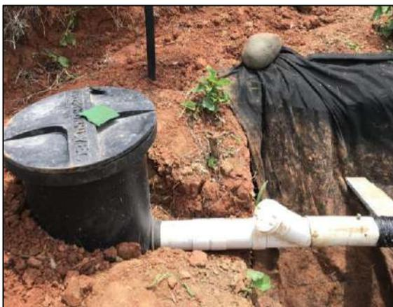
**Ilustración 4-12:** Conexión de tubos de PVC
