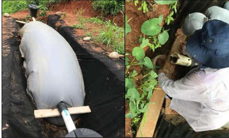
**Ilustración 4-24:** Desconectar el tubo PVC de la entrada
