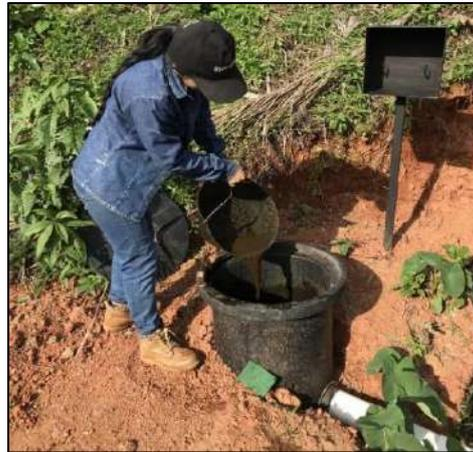
**Ilustración 4-17:** Carga del biodigestor
