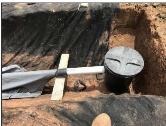
**Ilustración 4-13:** Ubicación tanque de salida del biol
