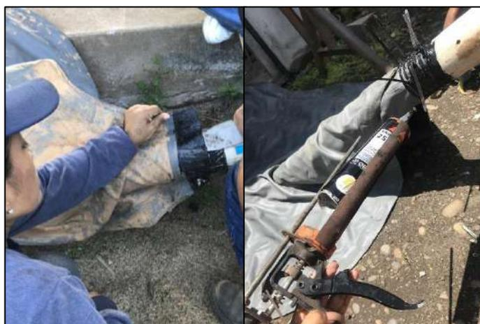
**Ilustración 4-28:** Desprendimiento de la geomembrana del tubo PVC
