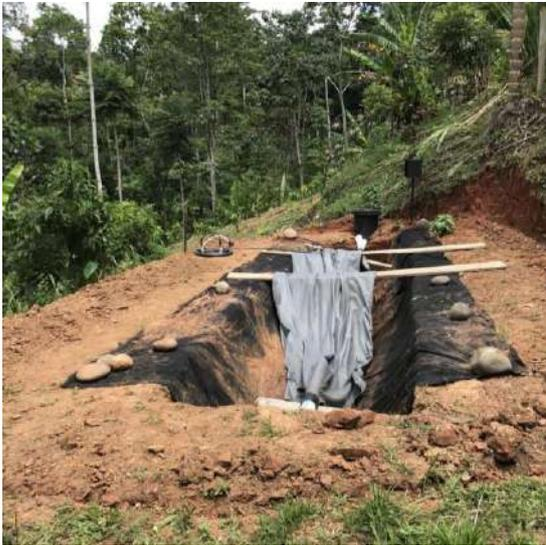
**Fotografía 1:** Mantenimiento e instalación del biodigestor tubular en el Centro de Investigación e Interpretación Biótica “La Belleza”
