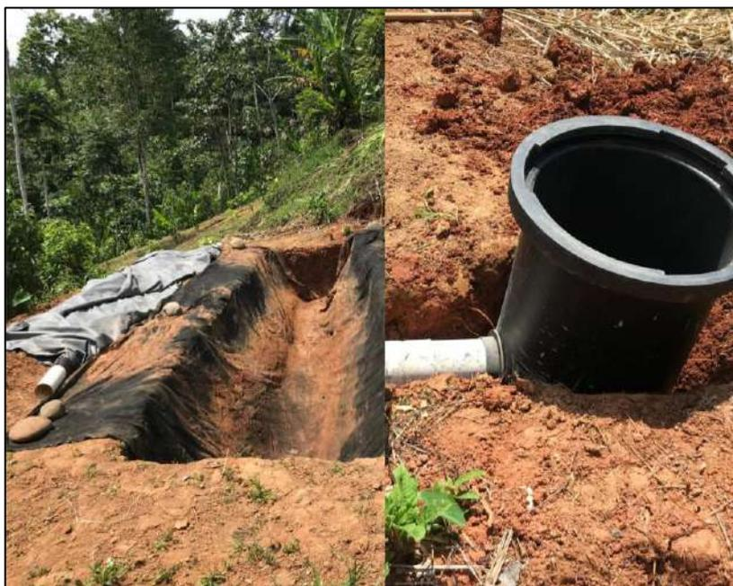
**Ilustración 3-4:** Instalación del biodigestor tubular en la zanja
