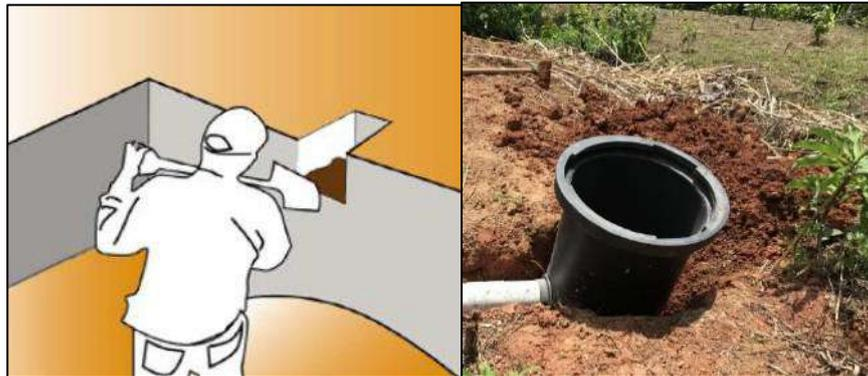
**Ilustración 4-10:** Excavación tanque de recepción
