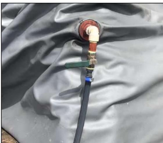
**Ilustración 4-14:** Conexión salida de biogás
