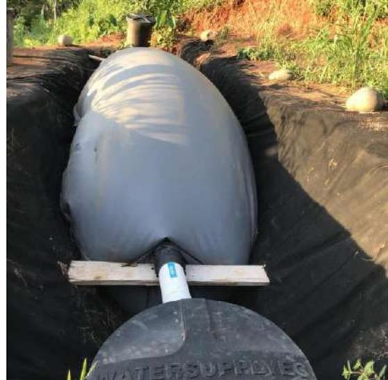
**Fotografía 2:** Biodigestor tubular a los 45 días de iniciar el proceso de digestión anaeróbica.
