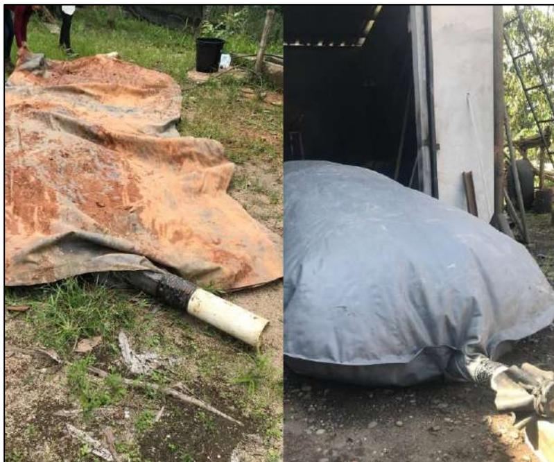
**Ilustración 3-2:** Mantenimiento del biodigestor tubular
