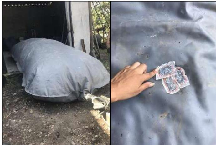
**Ilustración 4-30:** Reparación de agujeros de la geomembrana
