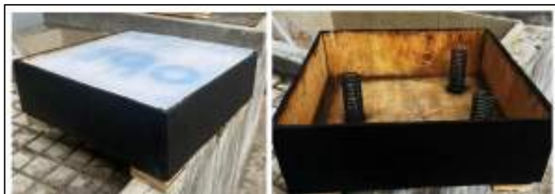
Ilustración 3-61: Construcción de la estructura
