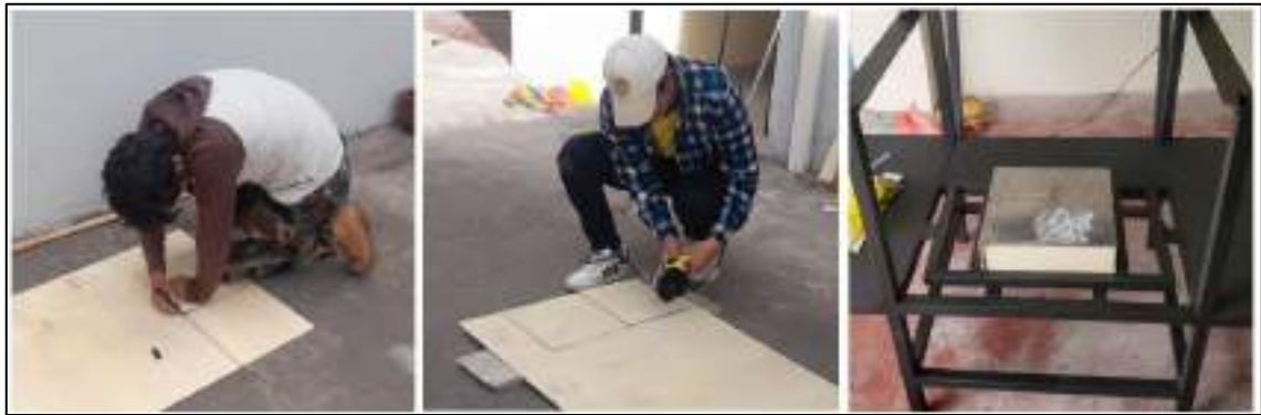
Ilustración 3-65: Construcción de sistema de vacío
