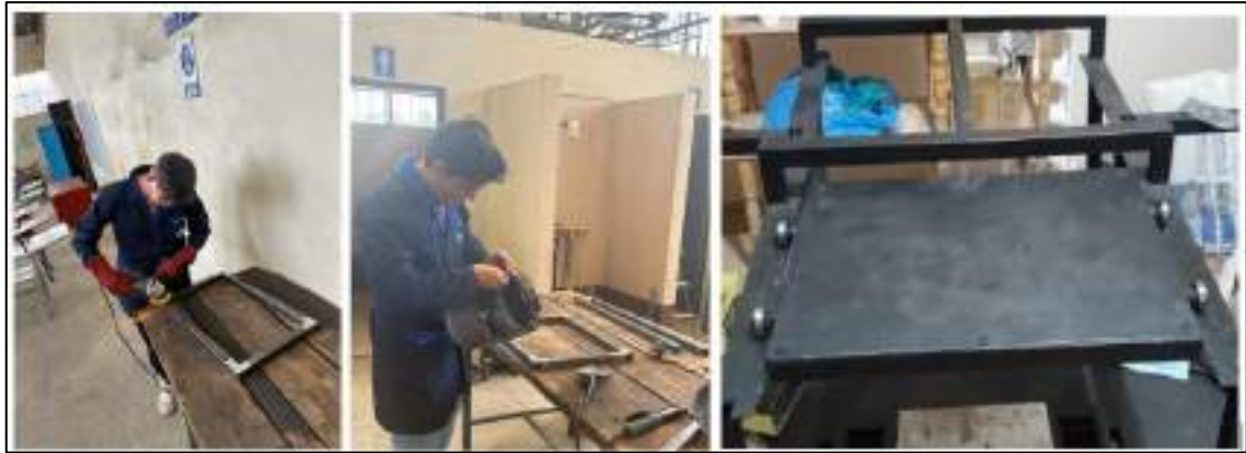
Ilustración 3-63: Construcción de módulo de calentamiento
