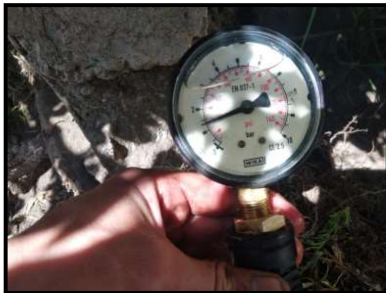
Ilustración 3-38: Medición de los aspersores Punto crítico 13
