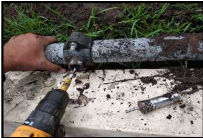
Ilustración 3-29: Instalación del collarín en los ramales principal y secundario
