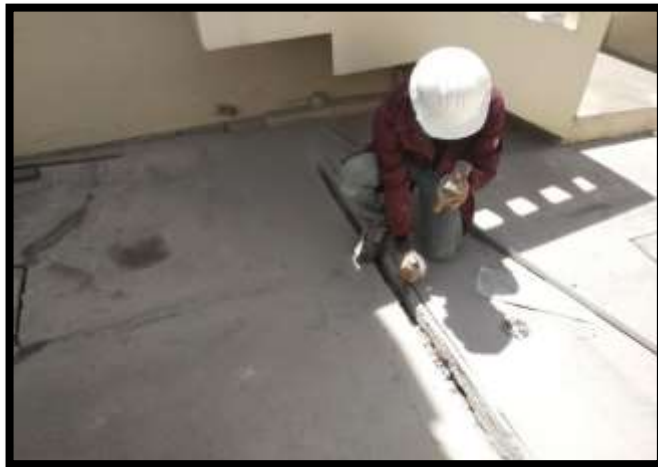
Ilustración 3-21: Removimiento de concreto, línea de alimentación de la bomba
