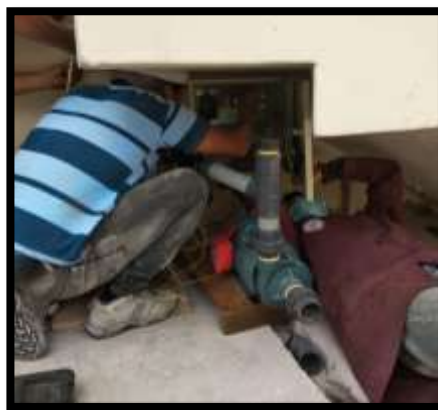
Ilustración 3-31: Instalación de una caja de control
