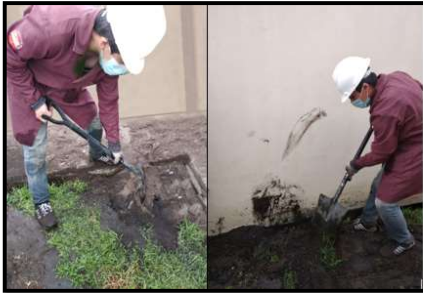
Ilustración 3-35: Relleno del zanjado
