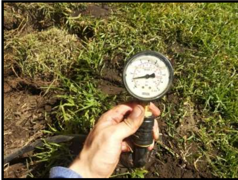
Ilustración 3-37: Medición de los aspersores Punto crítico 11
