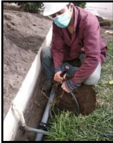
Ilustración 3-30: Instalación de los aspersores
