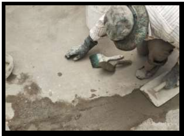
Ilustración 3-36: Relleno de concreto en la zona de circulación de la tubería
