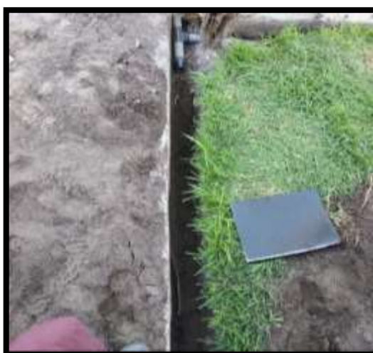
Ilustración 3-27: Instalación Tee, un reductor de 1 ½ a 1,
