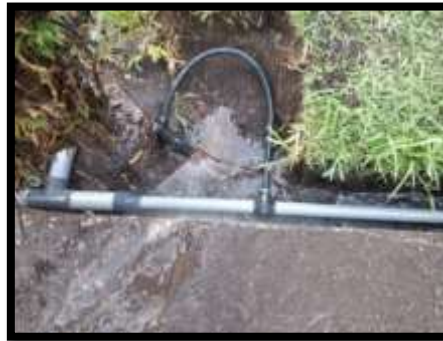
Ilustración 3-33: Pruebas de funcionamiento en los aspersores
