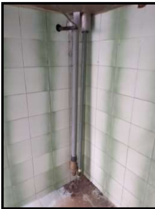
Ilustración 3-26: Instalación de la válvula de pie
