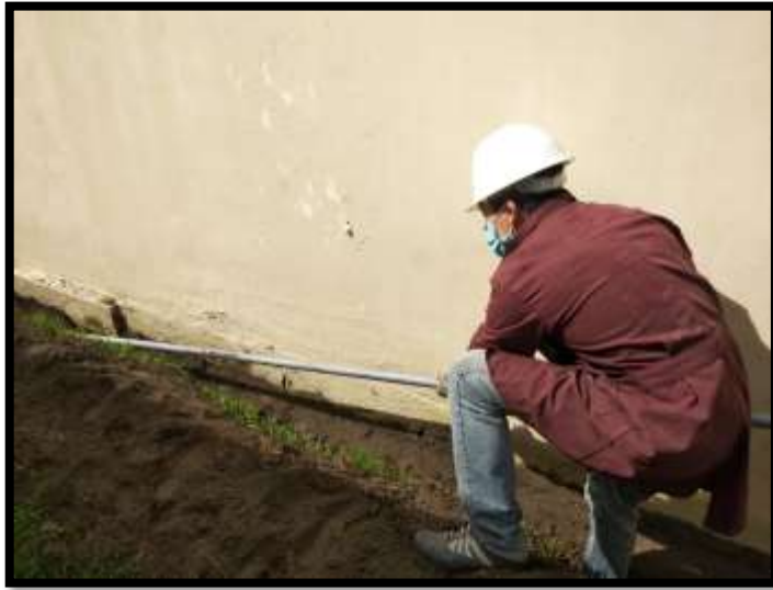
Ilustración 3-28: Instalación del ramal secundario sección 1,
