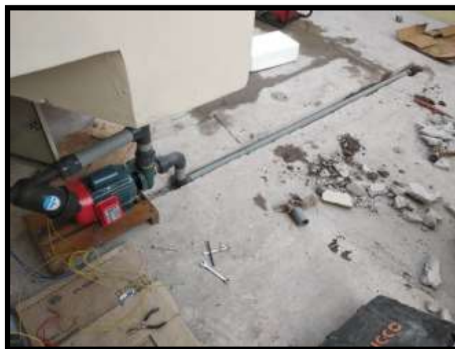
Ilustración 3-25: Instalación de la línea de alimentación de la bomba
