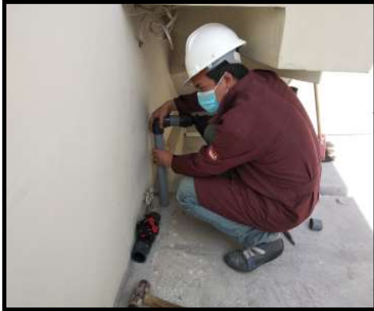
Ilustración 3-24: Instalación de la bomba
