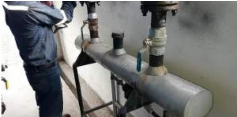
**Ilustración 2-19:** Manifold de salida del área de producción auxiliar
