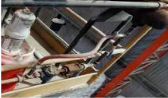
**Ilustración 4-27:** Trampa de vapor #1 y bypass
