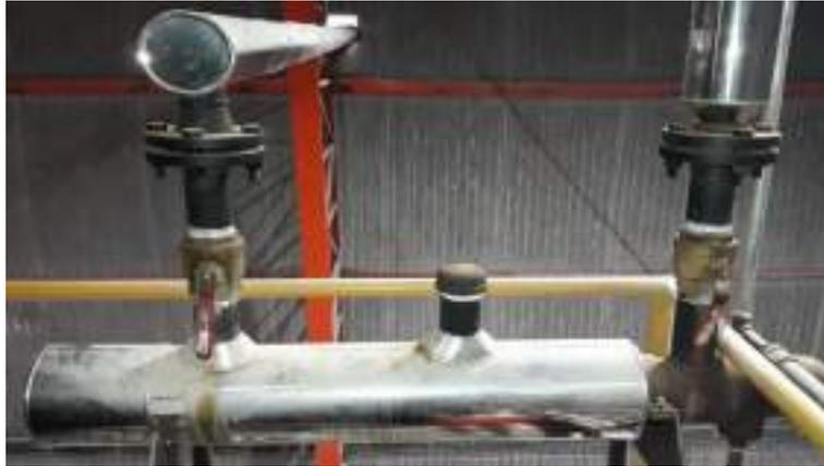
**Ilustración 2-20:** Manifold de llegada desde área de producción auxiliar
