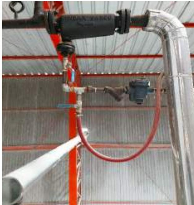
**Ilustración 4-28:** Trampa de vapor #2, separador de
