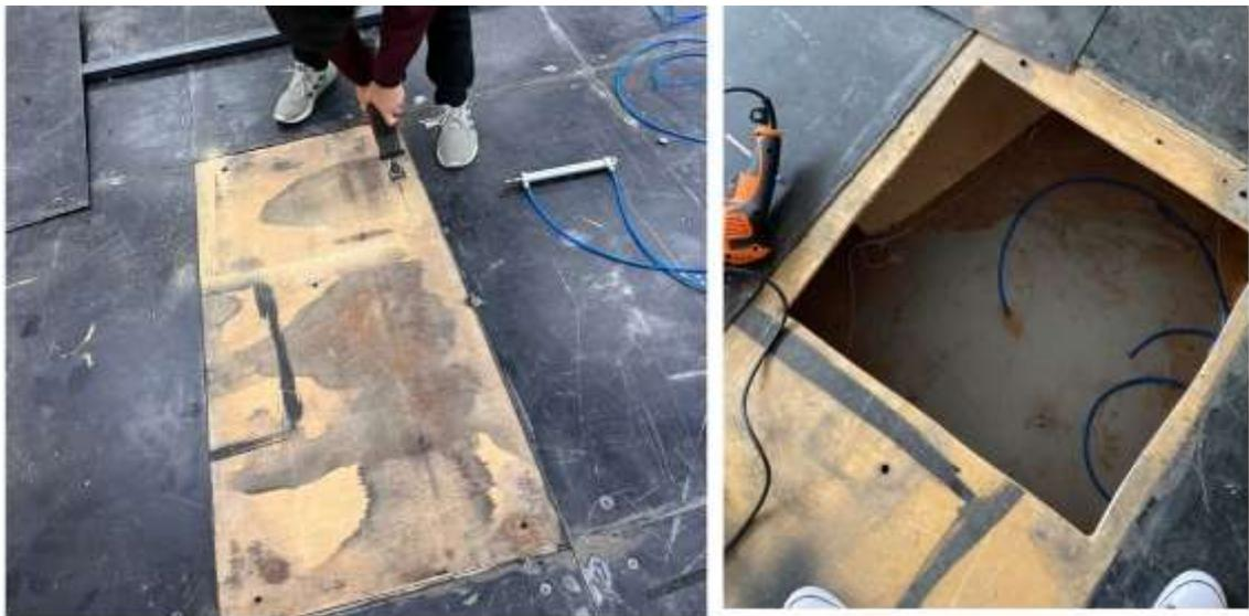
**Ilustración 4-1:** Corte de planchas de madera para ingreso de las trampas
