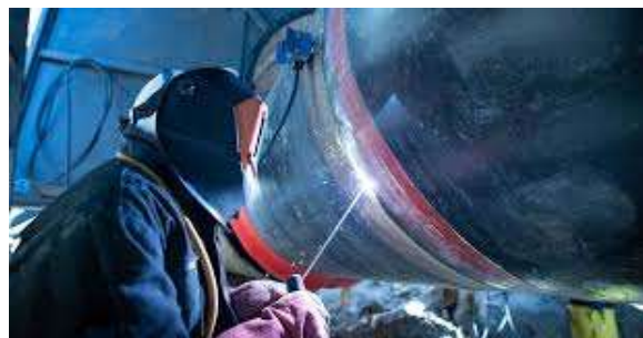
Ilustración 2. 14 Soldadura arco eléctrico
