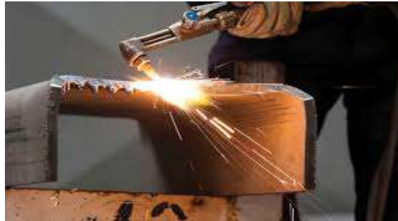
Ilustración 2. 15 Soldadura de gas
