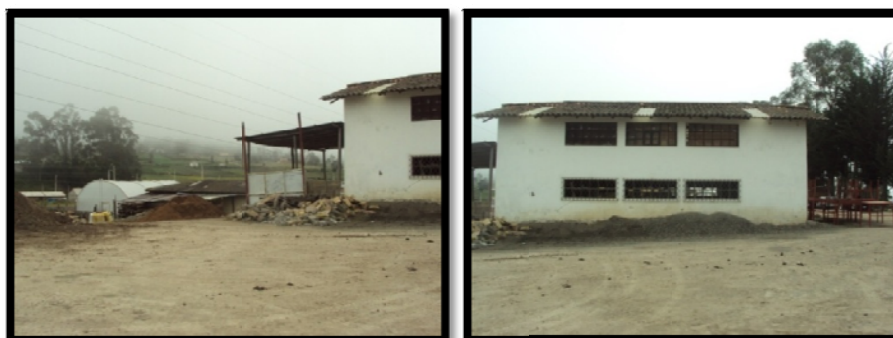
Figura 24. Espacios contiguos a la nave.
