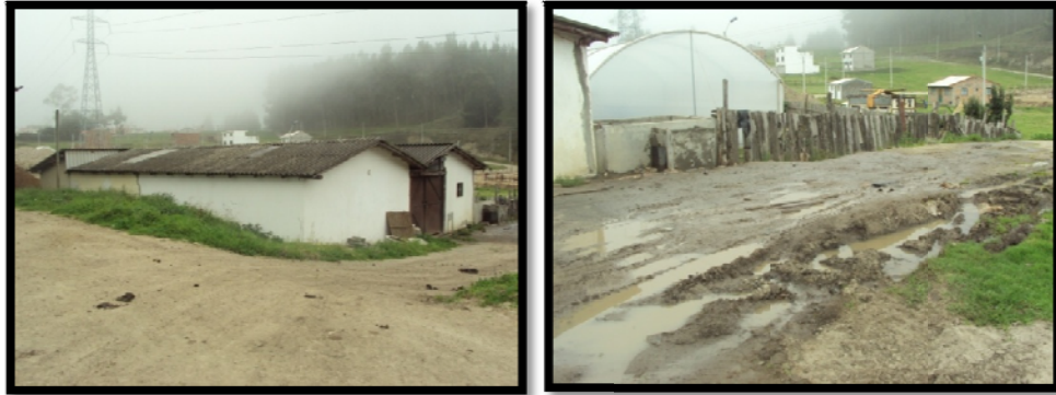
Figura 27. Nave secundaria e invernadero.
