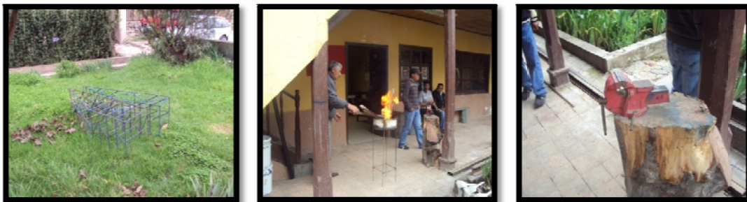
Figura 38. Deficiencias a la hora de realizar los trabajos.
