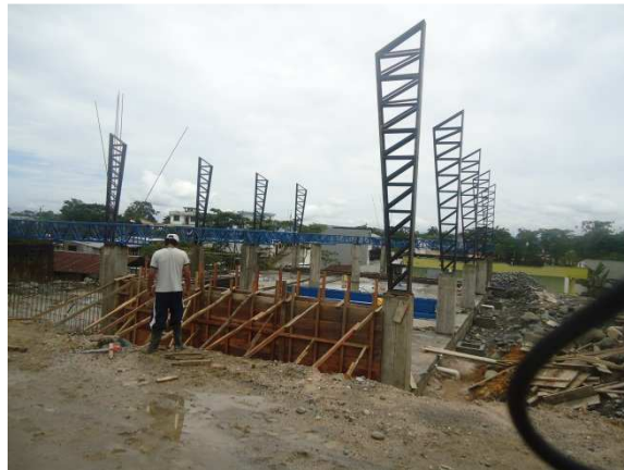
Figura 93. Construcción de la bodega general
