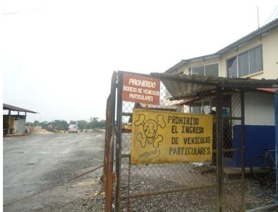
Figura 29. Señales sin las normas de señalización
