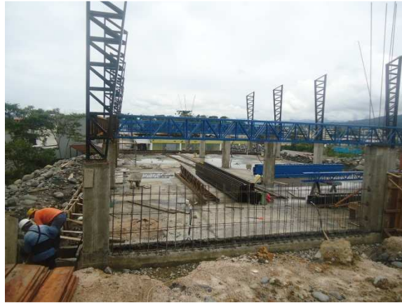
Figura 92. Construcción de la bodega general
