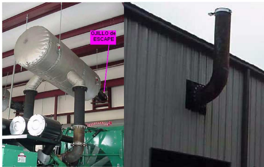
Figura 20. Características del escape del generador.
