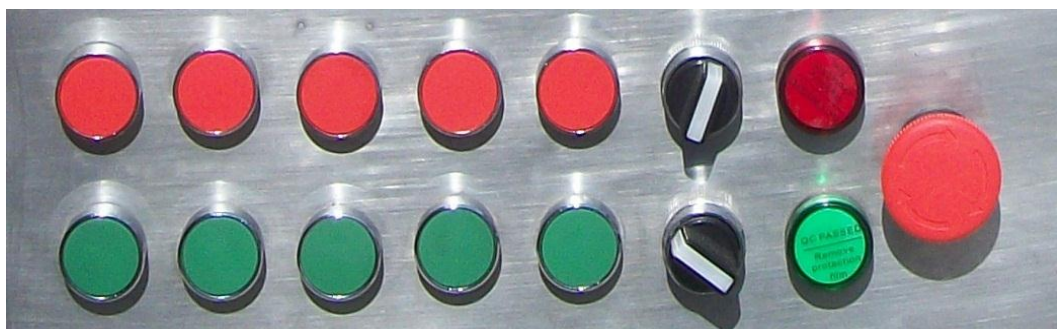
Figura 13. Montaje de selectores y lámparas piloto.
