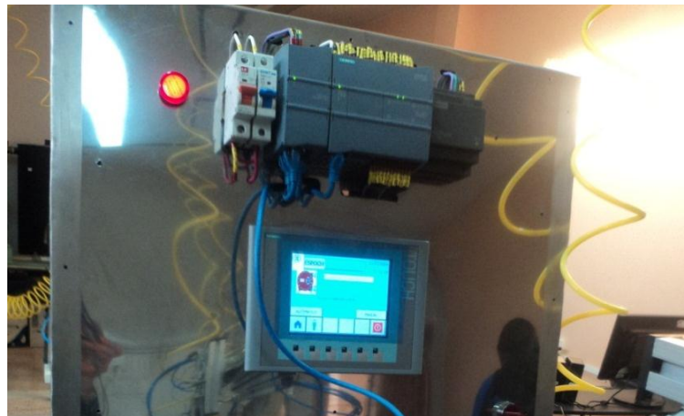
Figura 20. Módulo con sus elementos montados
