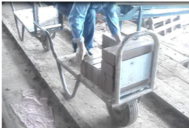
Figura 26. Carretilla para transporte de ladrillos.
