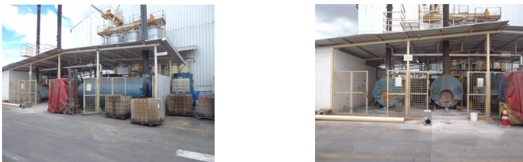
Fuente. Sala de calderos.
