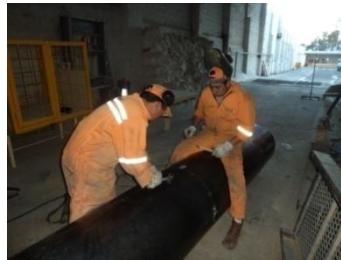
Figura 124. Supervisor de mantenimiento.
