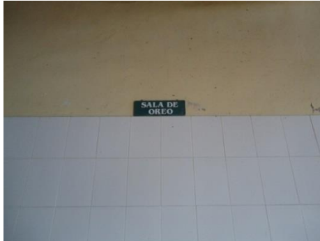
Figura 56. Señalización de seguridad deficiente
