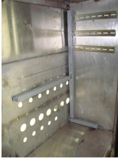
Figura 50. Montaje de canaletas ranuradas
