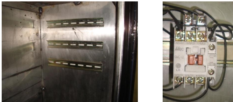
Figura 49. Montaje del riel DIN
