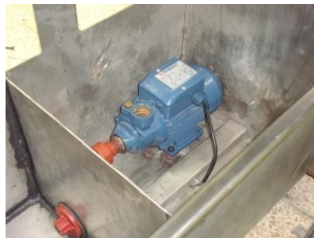
Figura 45. Montaje de la bomba centrífuga
