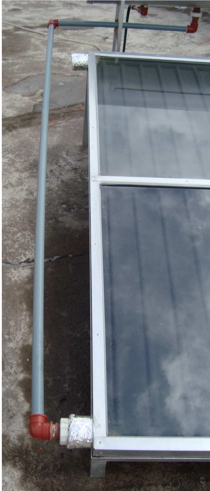
Fig. 4.8: Tubería y accesorios de ingreso de agua fría
