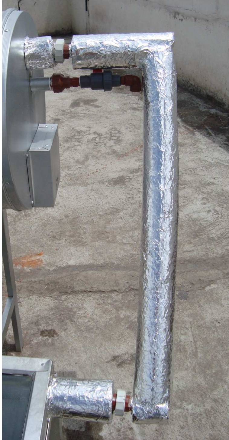
Fig. 4.9: Tubería y accesorios de salida de agua caliente
