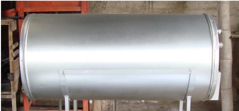
Fig. 4.7: Tanque reservorio aislado
