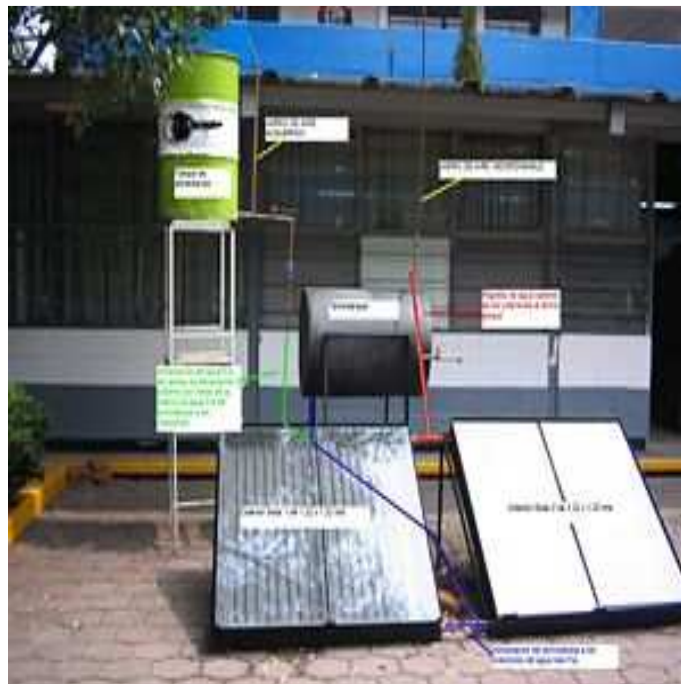
Fig. 3.4. Colector plano para calentamiento de agua
