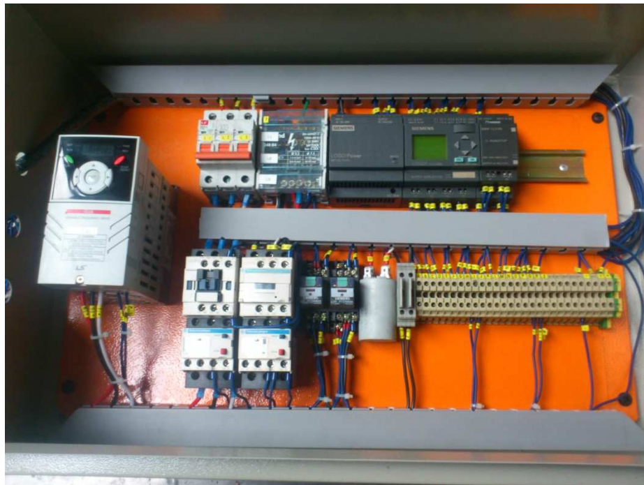
Figura III- 80. Montaje Final de Tablero de Control
