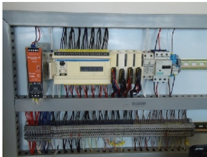
Figura IV.65 Funcionamiento del sistema de envasado con el cableado tradicional 76
