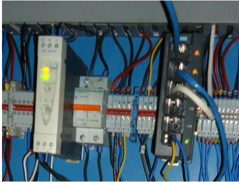
Fig. III.21. Ubicación del switch
