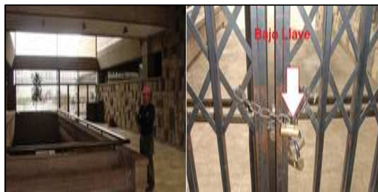
Figura 44. Salida de emergencia de la planta baja
