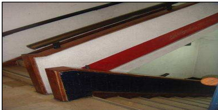
Figura 26. Escaleras de emergencias
