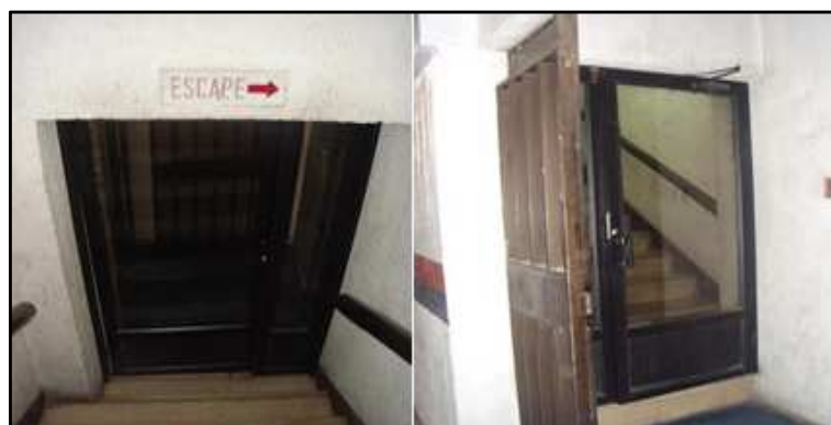
Figura 33. Salida de emergencias a parqueadero
