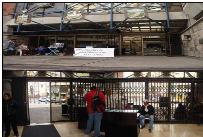
Figura 28. Salida de emergencias (frontal) planta baja
