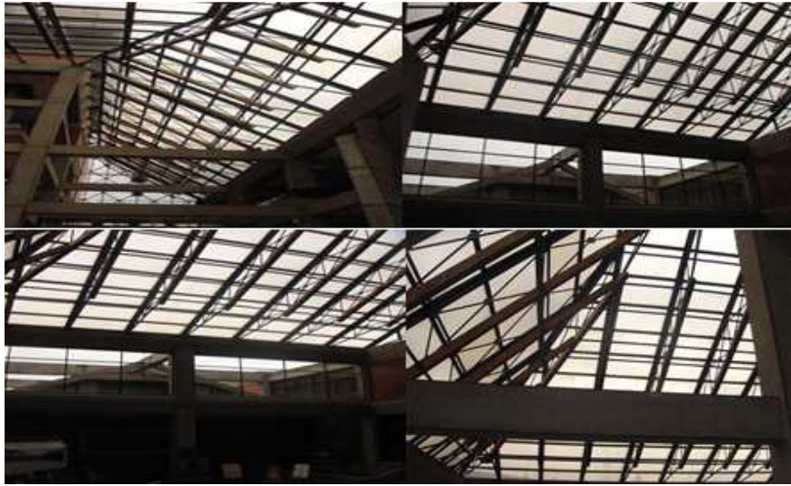
Figura 39. Tipo de techos en el edificio
