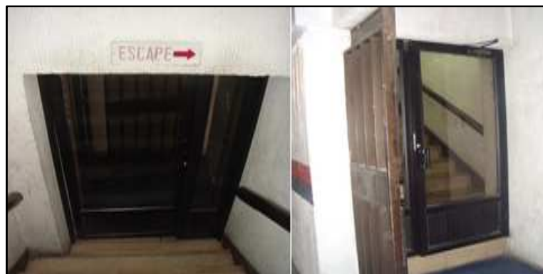
Figura 48. Salida de emergencia hacia parqueadero
