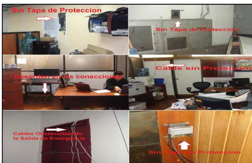
Figura 41. Defectos en instalaciones eléctricas
