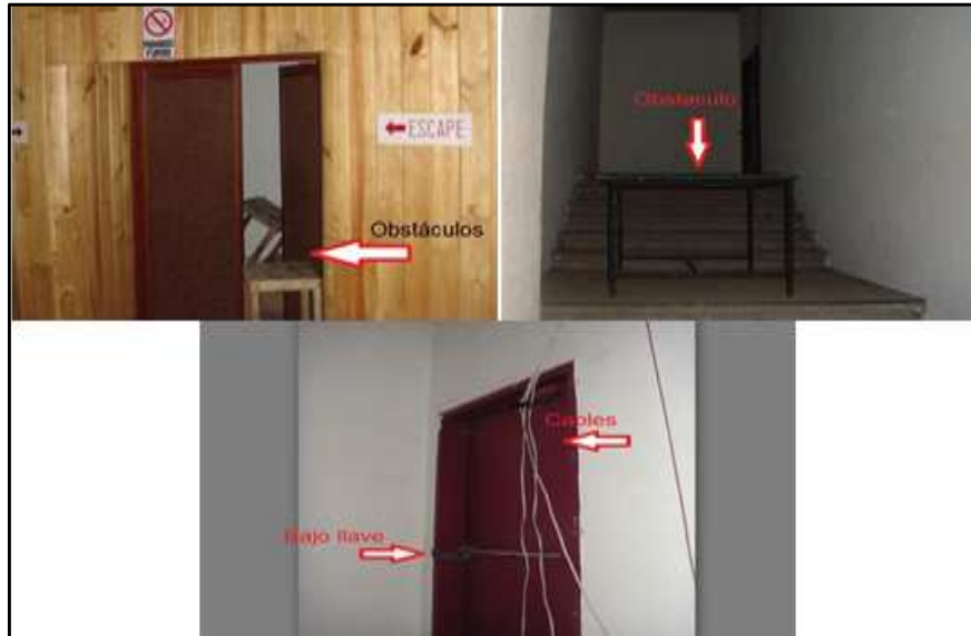
Figura 45. Salida de emergencia con obstáculos
