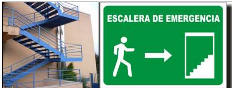
Figura 19. Escaleras de emergencia.
