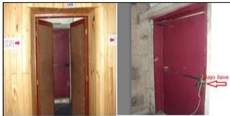
Figura 46. Salida de emergencia bajo llave
