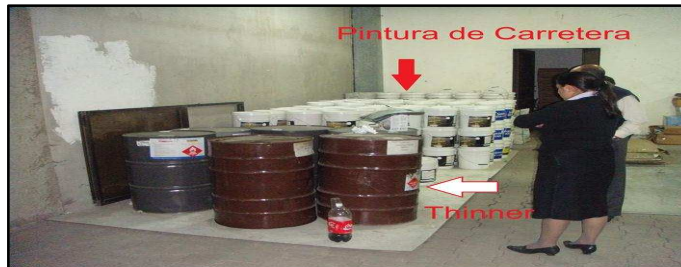
Figura 34. Bodega de materiales inflamables.
