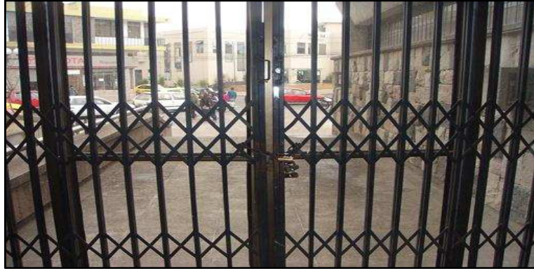
Figura 29. Salida de emergencias (Lateral) planta baja
