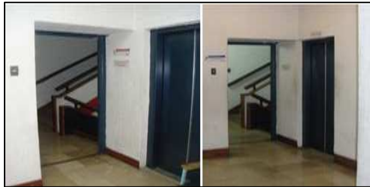
Figura 47. Salida de emergencia hacia escaleras
