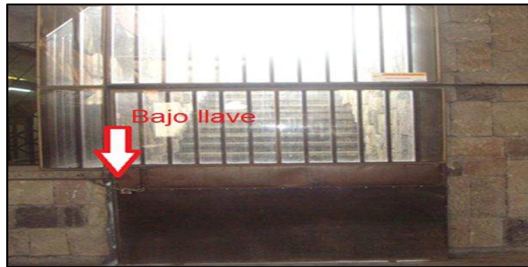
Figura 43. Salida de emergencia del subterráneo bajo llave
