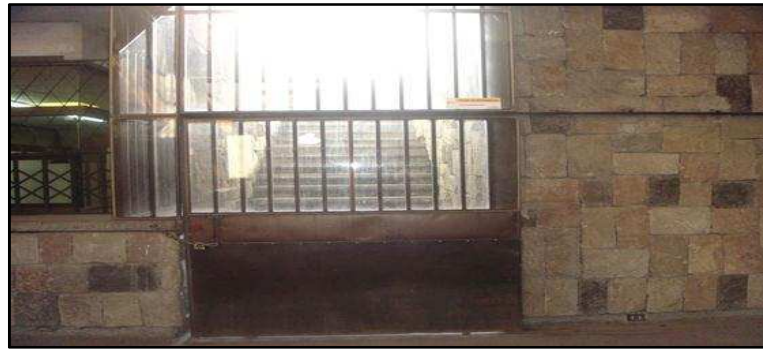
Figura 27. Salida de emergencias subterráneo
