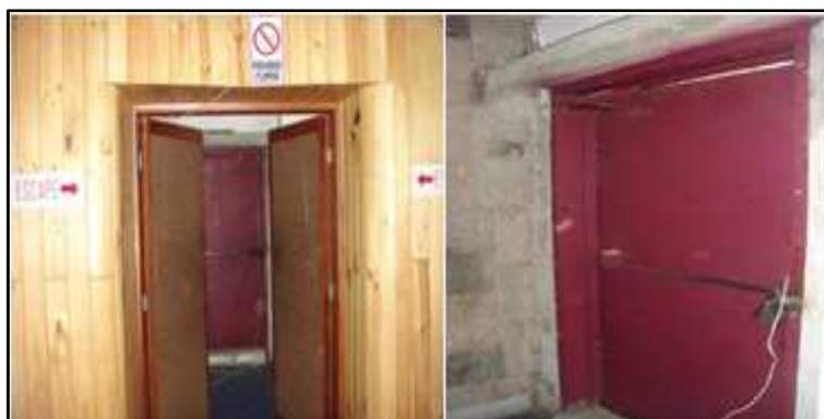
Figura 30. Salida de emergencias izquierda (auditorio)
