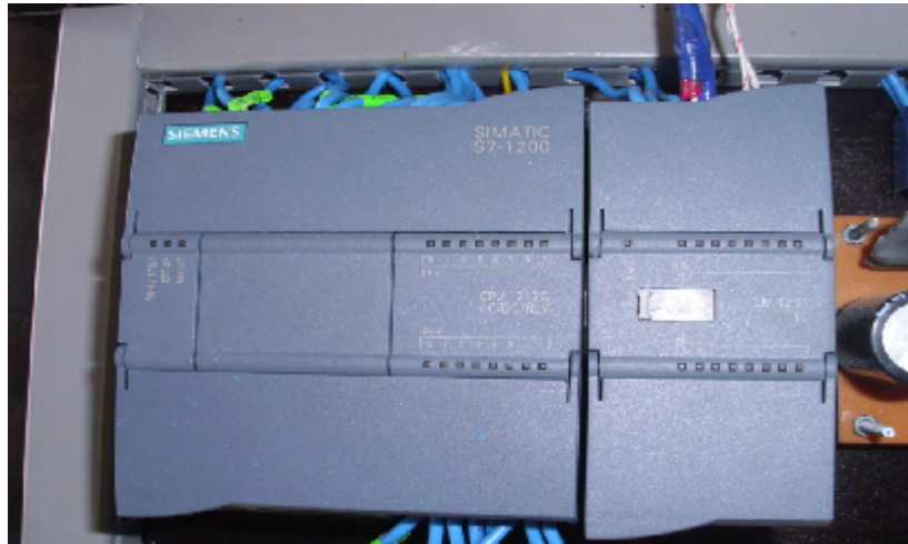
Figura III. 58 PLC SIEMENS S7 1200 – CPU 1212C + MODULO DE EXPANSIÓN SM 1231 TC
