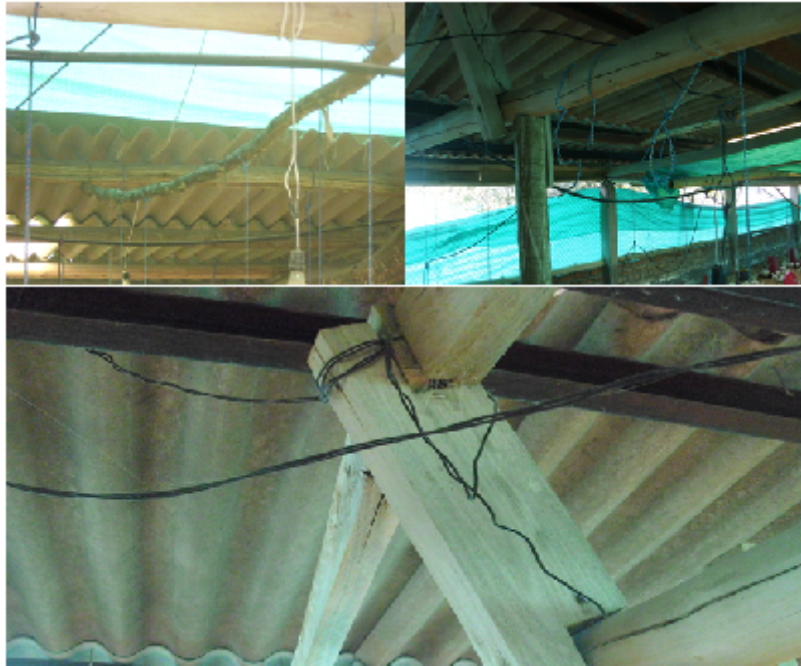
Figura III. 42 Instalaciones Eléctricas Anteriores.
