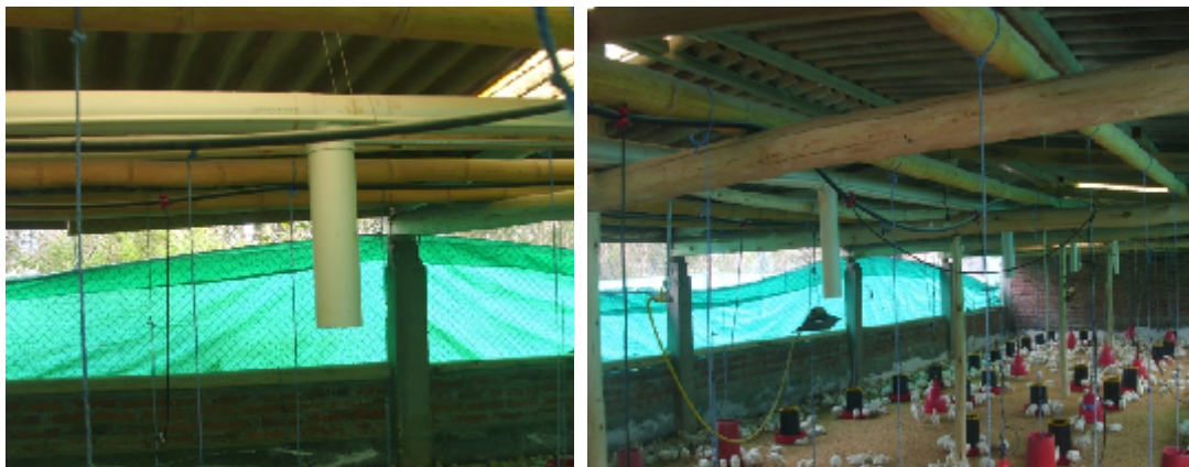
Figura III. 47 Sistema de tuberías en el interior del galpón 01 de la avícola Reina del Cisne
