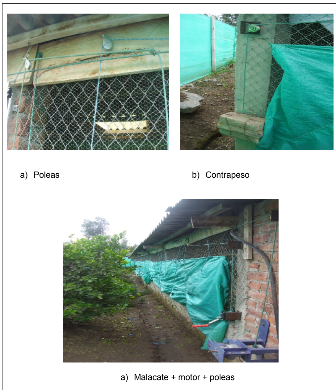
Figura III. 48 Sistema de apertura y cierre de cortinas
