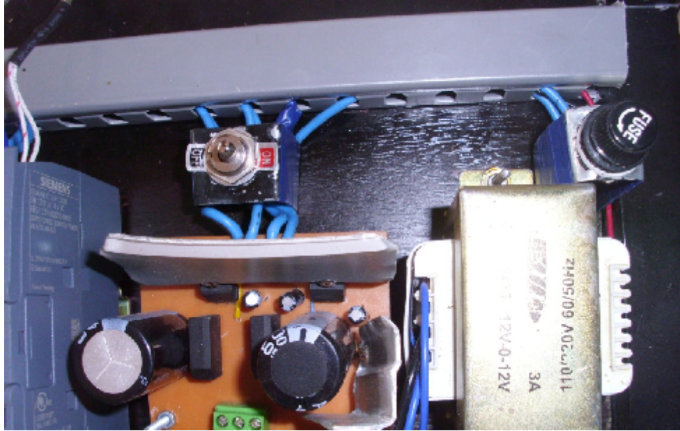
Figura III. 59 Fusible de 3 A. + Fuente 5VCD, 12 VCD y 24VCD
