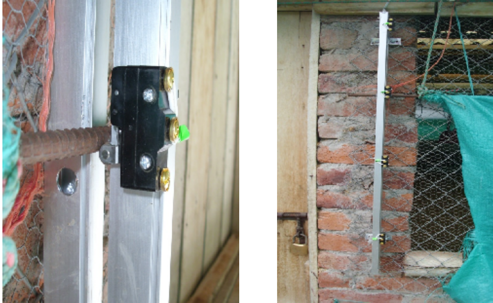
Figura III. 62 Sensor fin de carrera y estructura de soporte.
