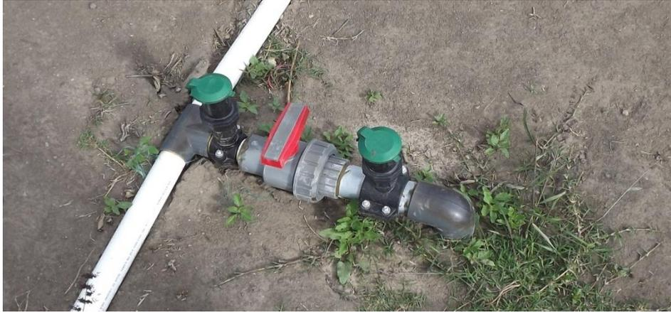
**Figura III. 21 Válvula principal de Riego del CER-IRRIFRUT**
