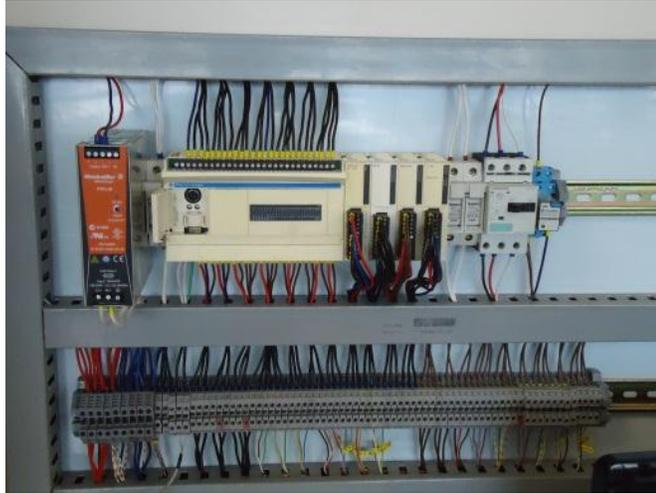
**Figura IV.20** Funcionamiento del mezclado con el cableado tradicional<sup>66</sup>
