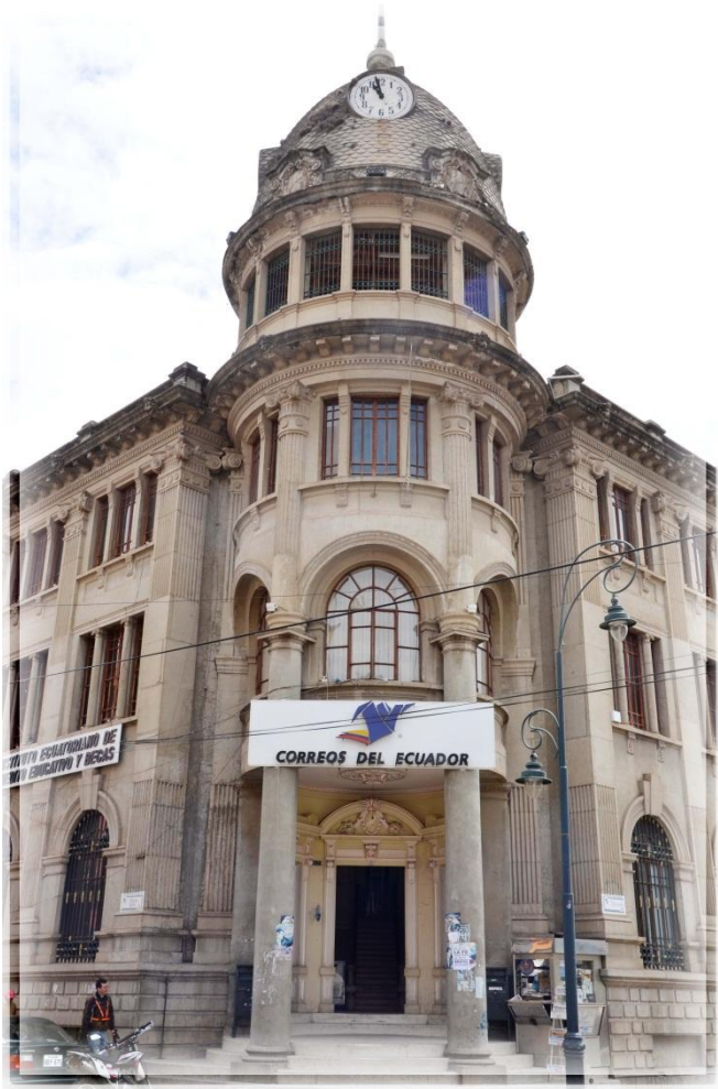
Fig. III. 29 Edificio del Correo
