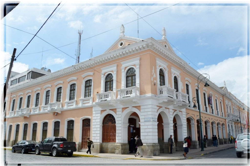
Fig. III. 40 Edificio del Municipio
