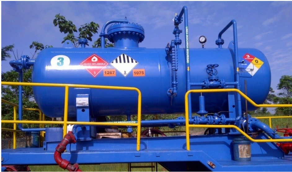
Figura 20. Acumulador de presión
