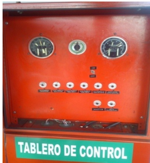
Figura 14. Tablero de control
