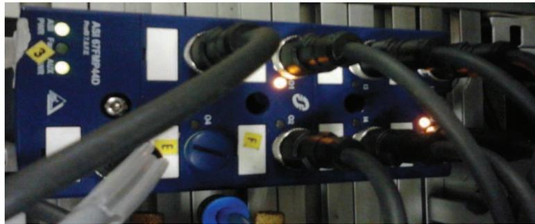
Figura V.17 Esclavos ASI 67FMP44D<sup>64</sup>
