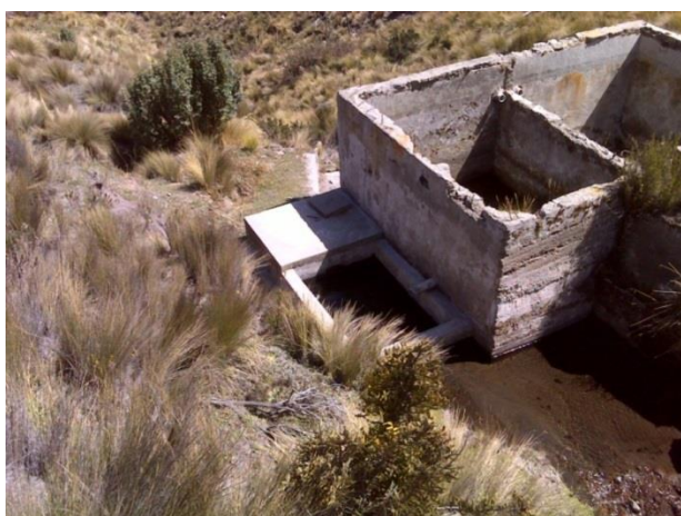
Fotografía 29. Reservorio para colecta de aguas de las vertientes y su posterior conducción. Julio 2013.
