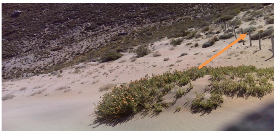
Fotografía 22. Sistema de protección mediante postes en las vertientes de agua. Comunidad Chorrera Mirador. Julio 2013
