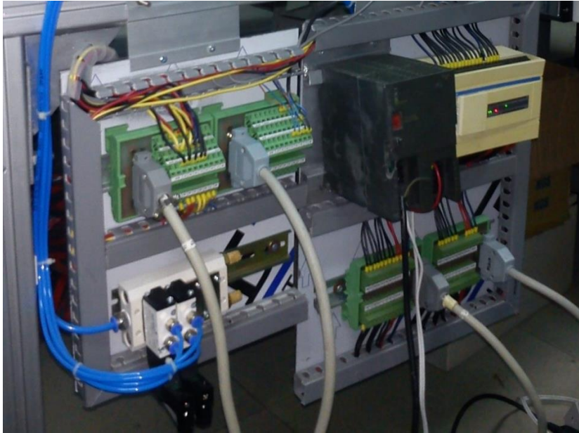
Ilustración III-27: Montaje del tablero de control
