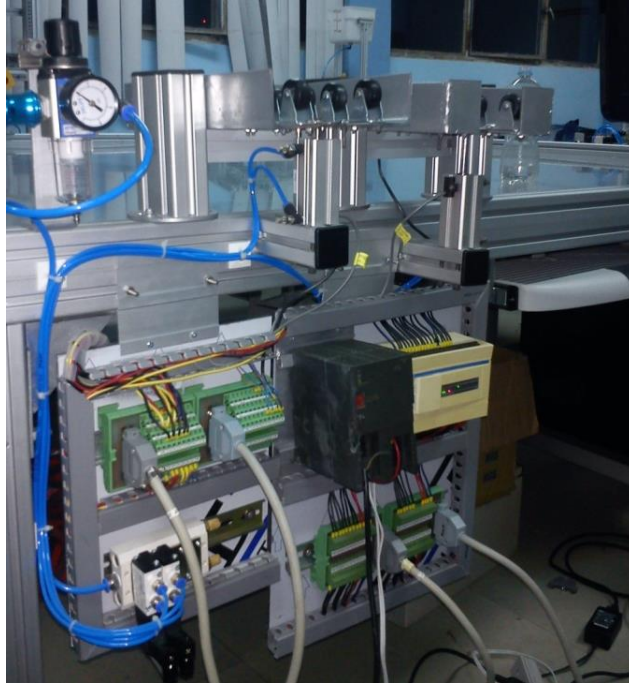
Ilustración III-21: Sistema neumático de la estación de paletizado
