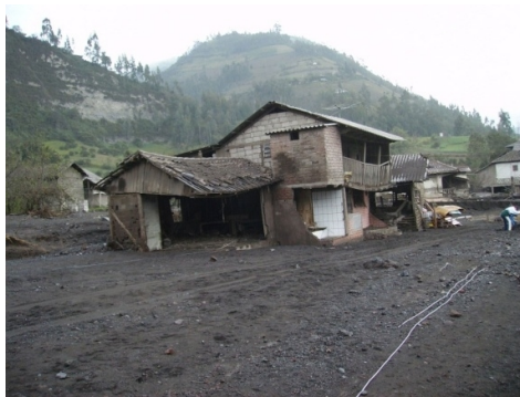
Figura I. Nº 7: Afectación http://www.alertatierra.com
