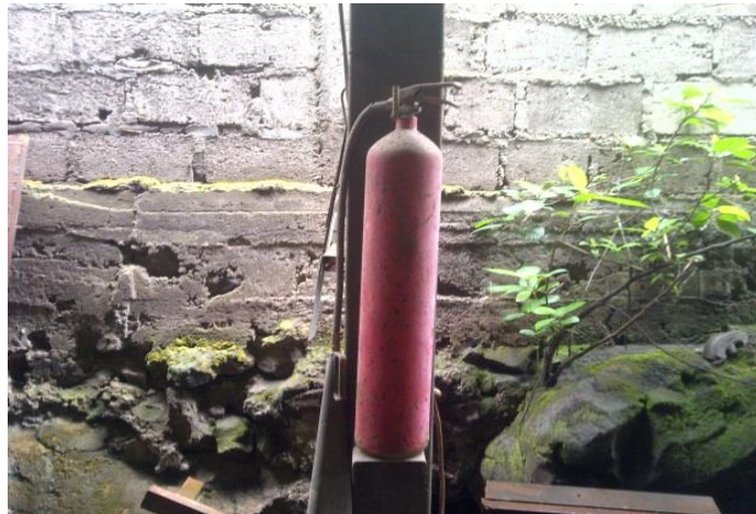
Figura 41. Extintor en el área de ensamblado
