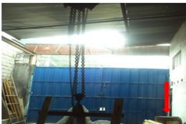
Figura 27. Transporte y almacenamiento de químicos
