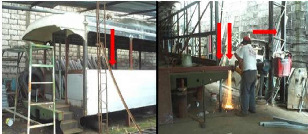
Figura 20. Caídas de objetos por derrumbamiento o desprendimiento
