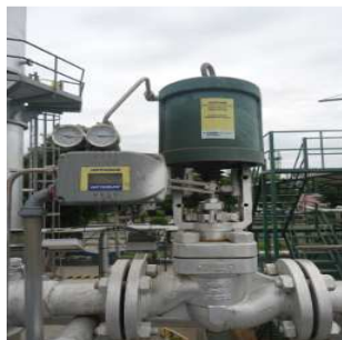
Figura 31. Válvula de control de alimentación de agua
