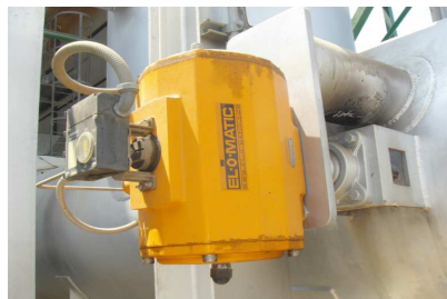
Figura 28. Actuador neumático
