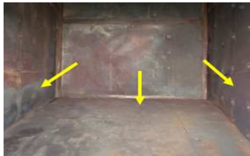
Figura 39. Inspección interior ducto de transición
