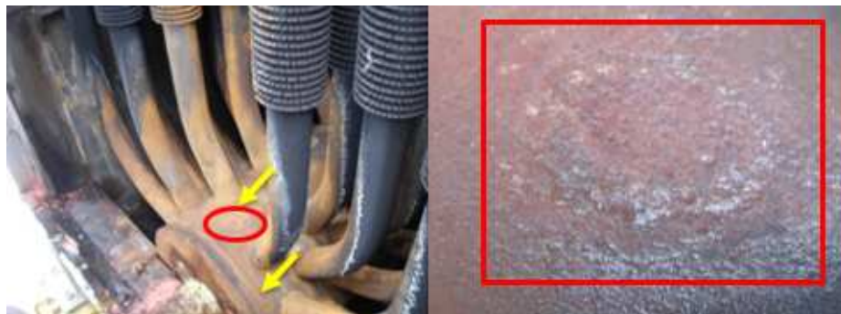
Figura 41. Inspección interior cabezal inferior evaporador 1
