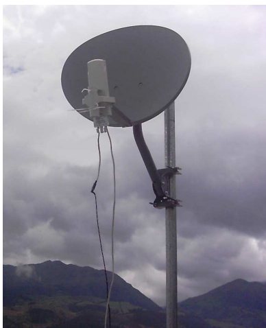
Figura.V.68 SM Instalado en Tunshi
