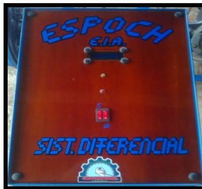
Figura 75. Tablero de control
