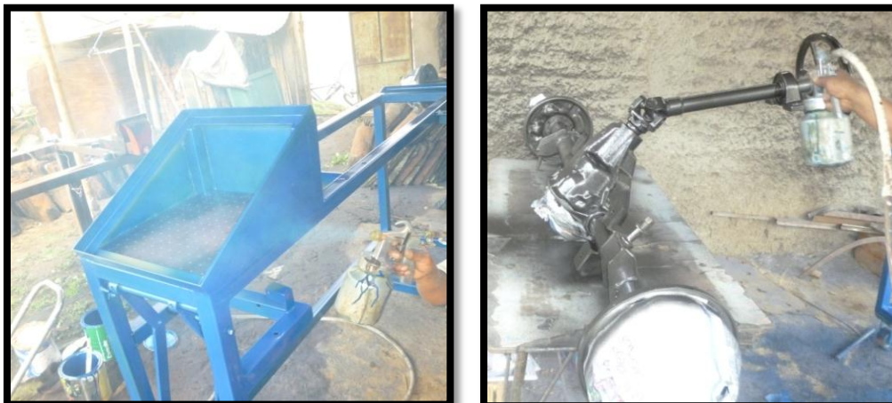
Figura 66. Pintado del bastidor y puente trasero
