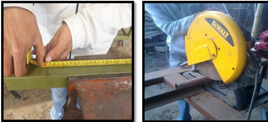
Figura 61. Cortado del tubo estructural
