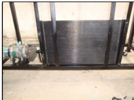
Figura 54. Instalación del condensador
