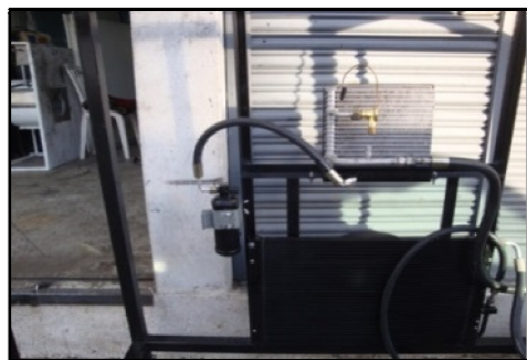
Figura 56. Instalación del filtro deshidratante
