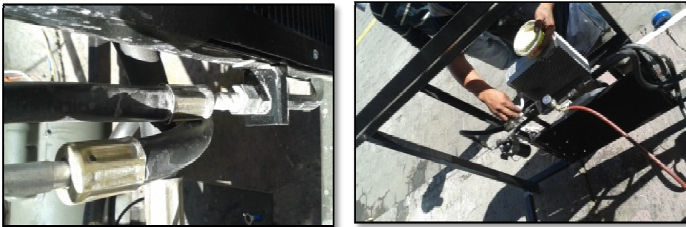
Figura 67. Comprobación de fugas
