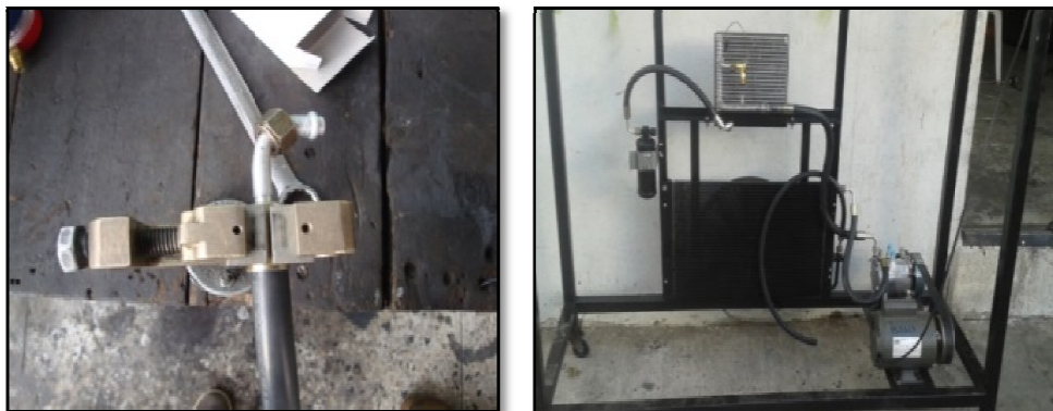
Figura 60. Instalación de las mangueras y acoples
