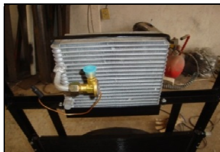
Figura 58. Instalación del evaporador
