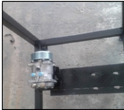
Figura 53. Instalación del compresor
