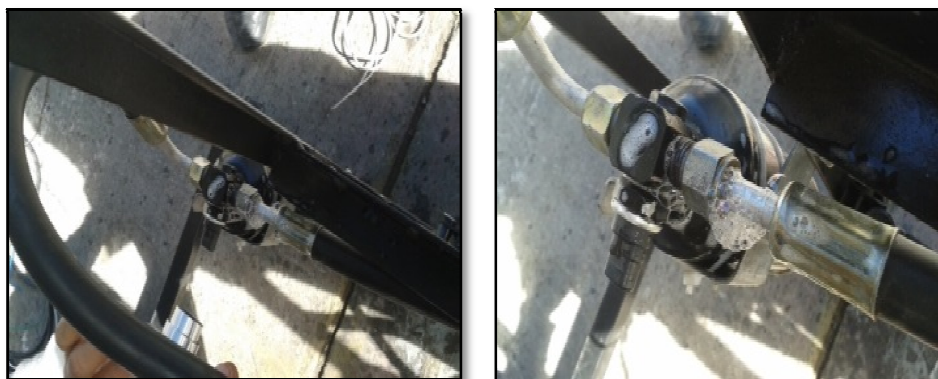
Figura 68. Fugas en el filtro deshidratante
