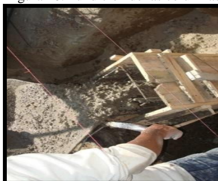
Figura 48. Fundición de las columnas
