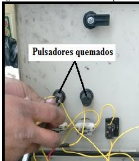
Figura 23. Pulsadores eléctricos quemados
