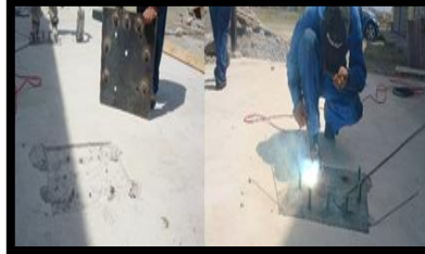
Figura 55. Colocación de la placa
