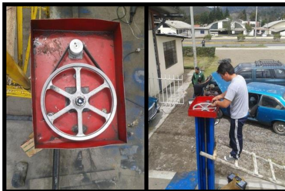
Figura 72. Colocación de poleas
