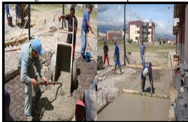
Figura 53. Fundición de la plataforma
