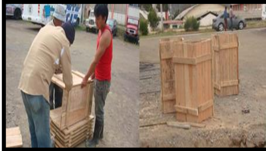
Figura 46. Armadura de las columnas
