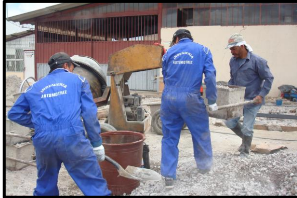
Figura 52. Dosificación del concreto
