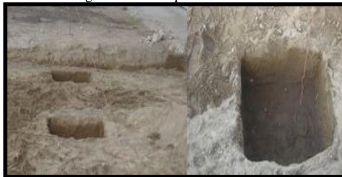
Figura 41. Bases para las columnas
