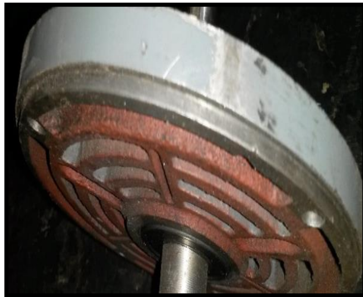
Figura 19. Soporte base desgastado
