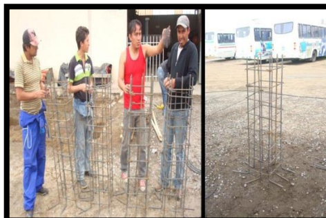
Figura 42. Sujeción de varillas de hierro
