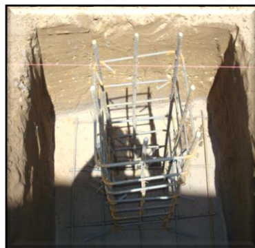
Figura 45. Colocación de la mezcla de concreto
