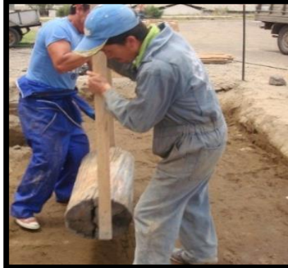
Figura 49. Compactando el piso
