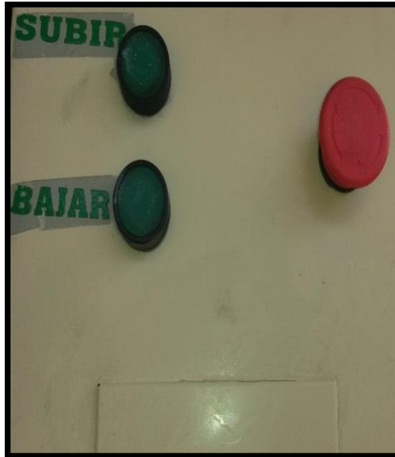
Figura 22. Carcasa de pulsadores desgastada
