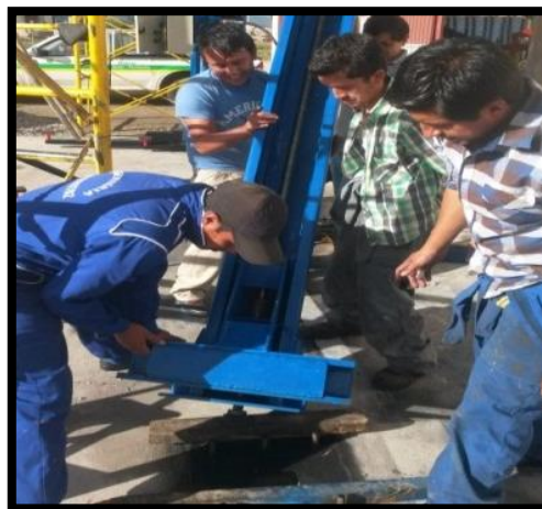
Figura 68. Posicionamiento de las columnas
