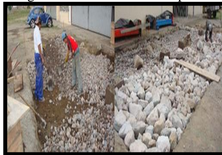
Figura 50. Colocación de la piedra
