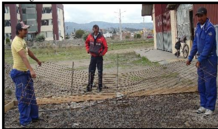
Figura 51. Colocación de la malla electro soldada
