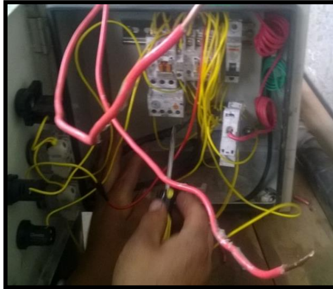
Figura 24. Conductores en mal estado
