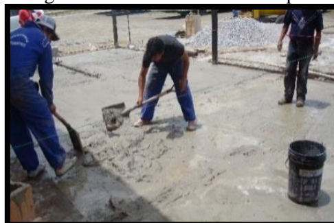
Figura 54. Masillado del contra piso
