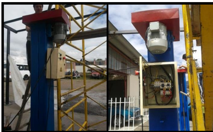
Figura 74. Montaje del motor y caja de mandos
