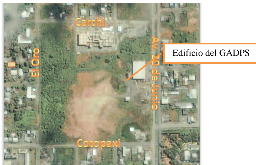
Figura. 7. Vista aérea del edificio del GADPS.
