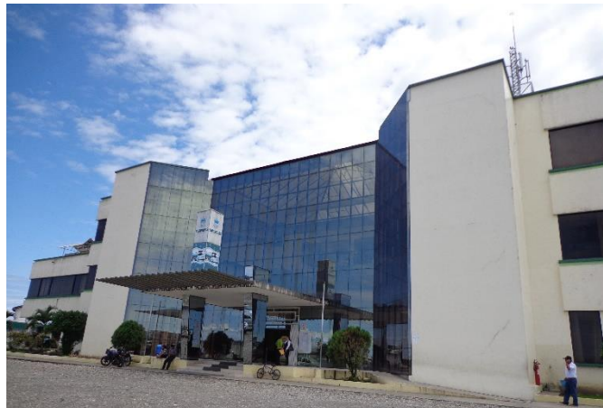
Figura. 6. Fachada principal edificio del GADPS.
