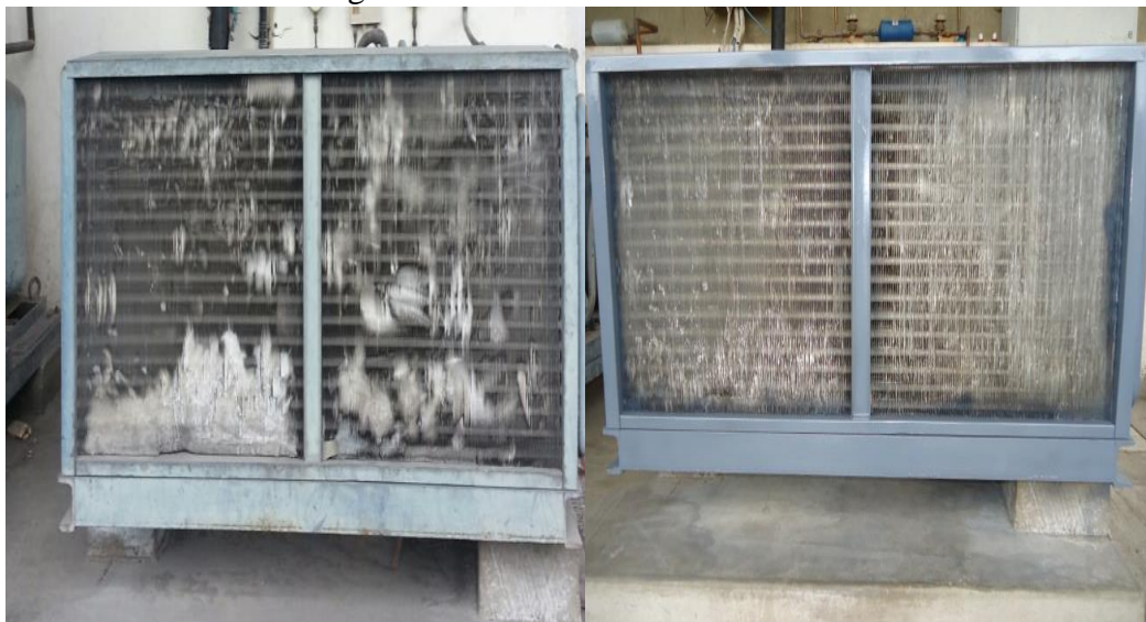
Figura 22. Aletas del condensador
