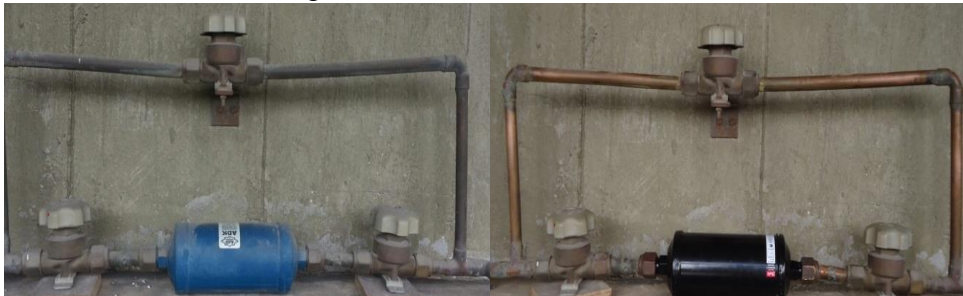
Figura 25. Filtro deshidratador
