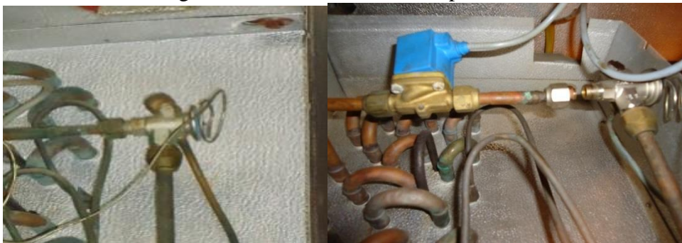
Figura 26. Válvula de termo expansión
