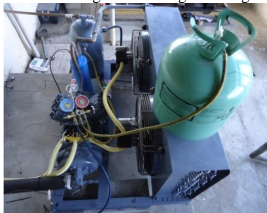
Figura 37. Carga de refrigerante.
