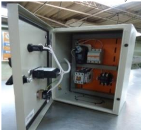
Figura 30. Armado del tablero de control y distribución.
