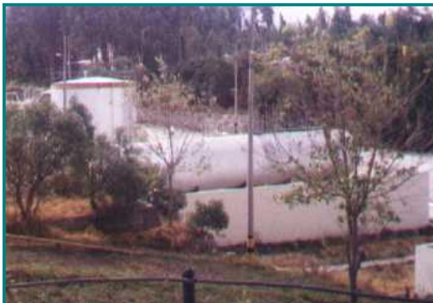
**Foto 1.11.6.1-4 Tanques de Almacenamiento de Agua Tipo Salchicha**
