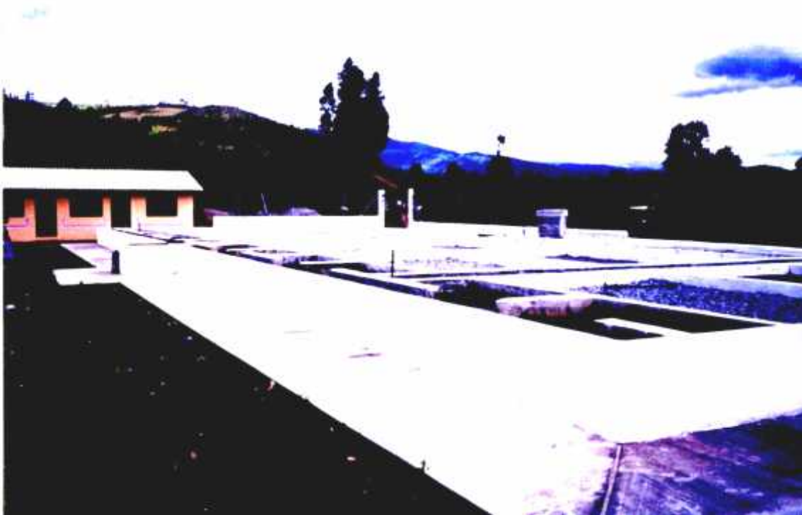
FIGURA 3.2. TANQUES DE FILTROS DE ARENA Y CLORACION.
