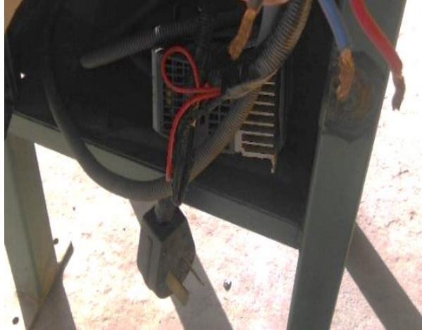
Figura 27. Conductores eléctricos rotos
