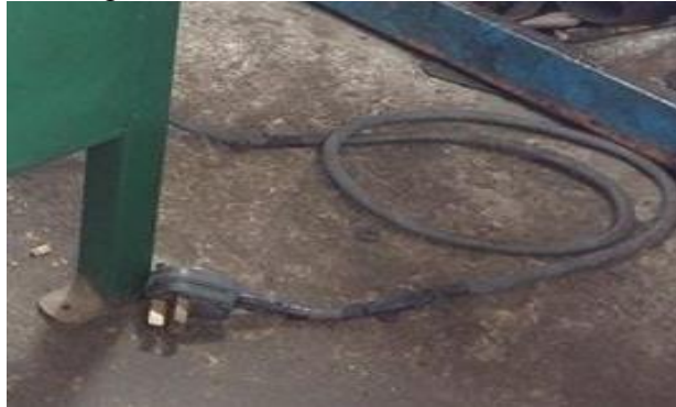
Figura 36. Cables de conexión dañados
