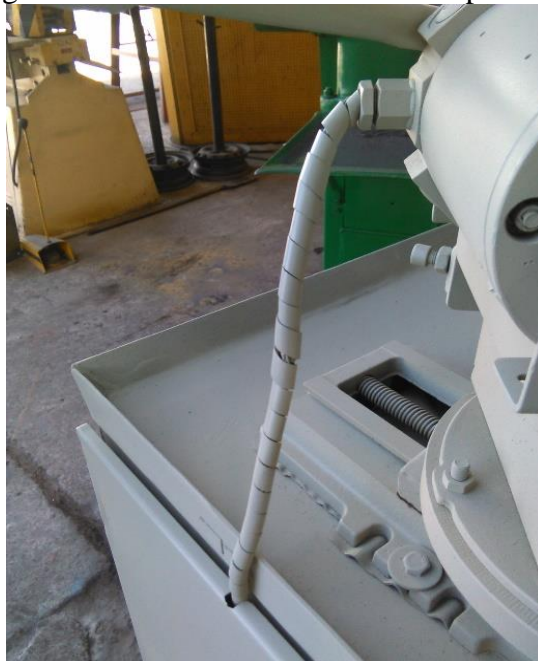
Figura 92. Conductores eléctricos remplazados
