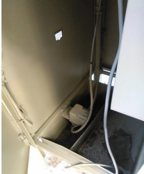
Figura 93. Sistema de refrigeración instalado
