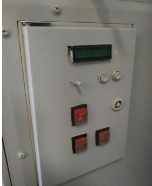
Figura 91. Variador de frecuencias limpio
