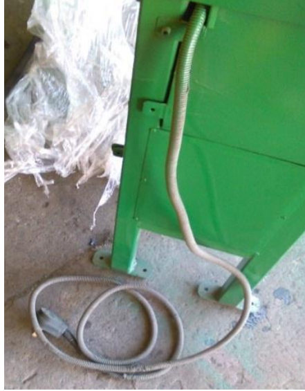
Figura 83. Cables de conexión remplazados
