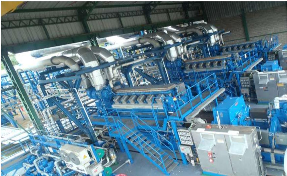
Figura 1.2. Imagen de los Motores de Combustión Interna Wartsila VASA 12V 32 LN montados en paralelo de la Estación Cayagama.
