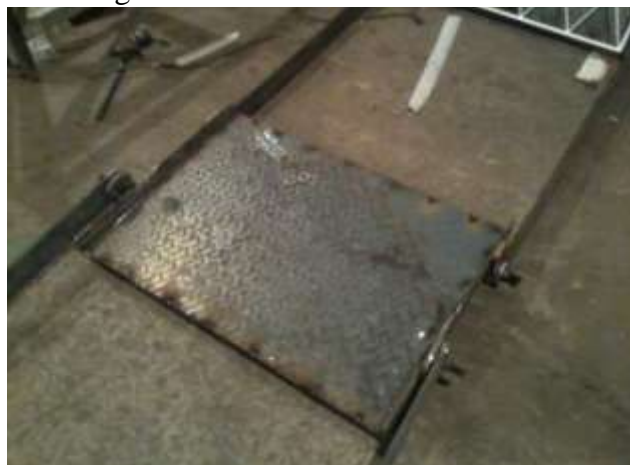
Figura 69. Colocación de eslabones
