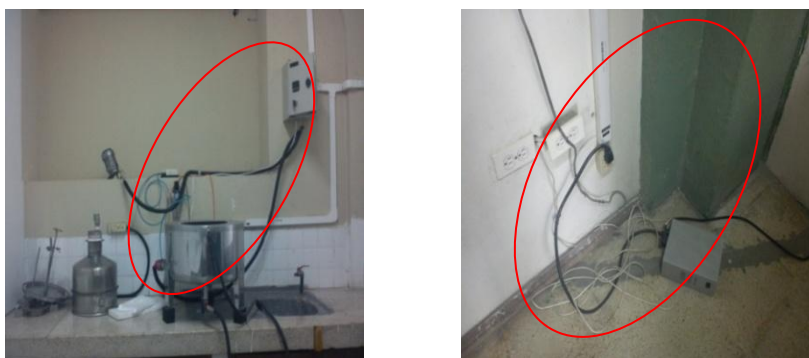
Figura 42: Malas instalaciones de cables.
