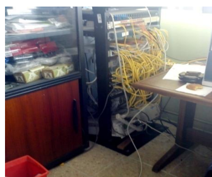
Figura 57 b: Peligro de incendio.
