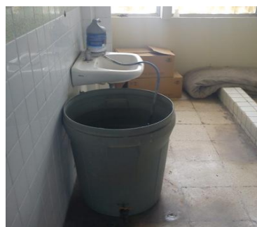
Figura 52 b: Baños sin agua.
