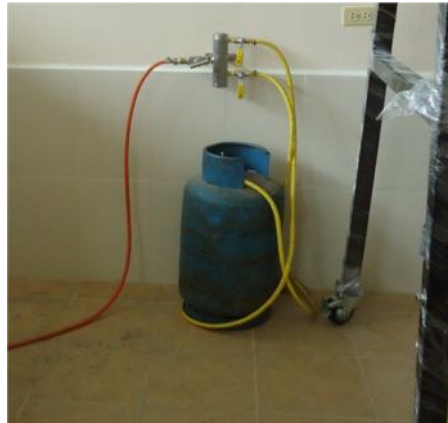
Figura 154. Tanque de gas junto a equipo a temperatura elevada
