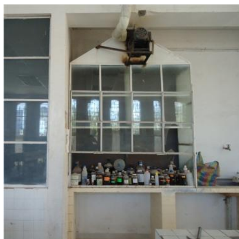
Figura 30. Falta de mantenimiento a campanas de extracción
