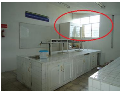
Figura 129. Falta de ventilación en el laboratorio de química general e inorgánica
