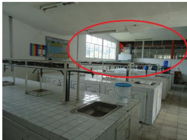
Figura 131. Falta de ventilación
