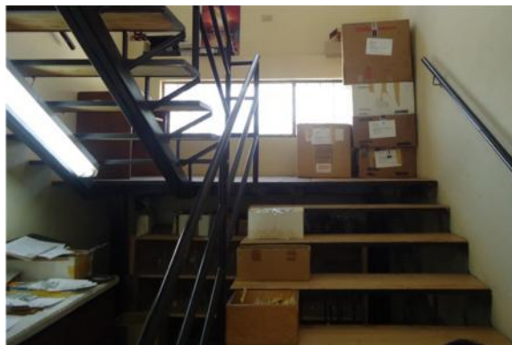
Figura 33. Espacio físico reducido
