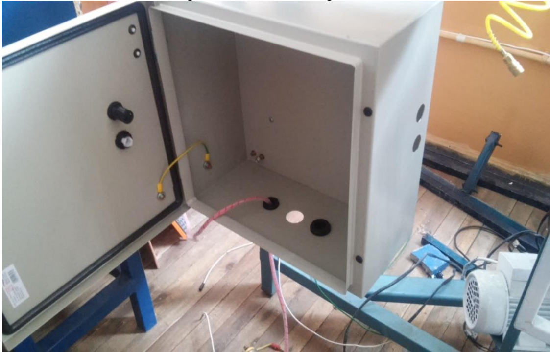
Figura 7 Instalación del gabinete
