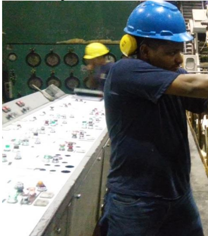
Figura 4 Consola de control
