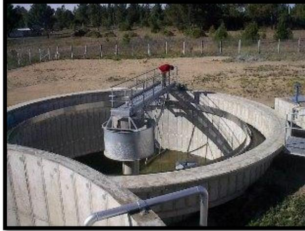
**Figura 9-1: Sedimentador secundario**
