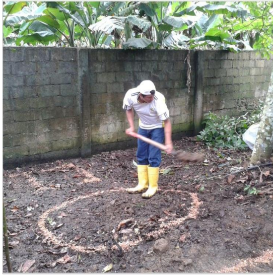
Selección del área donde se construirá el biodigestor.
