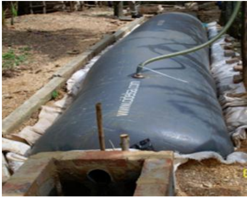
Figura 5-1. Biodigestor de polietileno.
