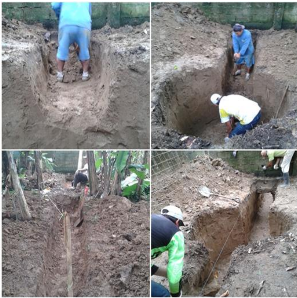
Excavación de la zanja de salida de lodos.
