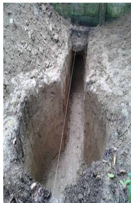
Excavación de la zanja de salida de biol.
