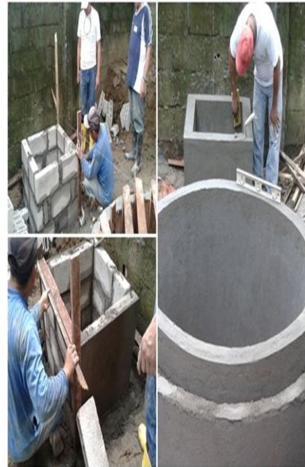
Construcción de la caja de salida de biol.
