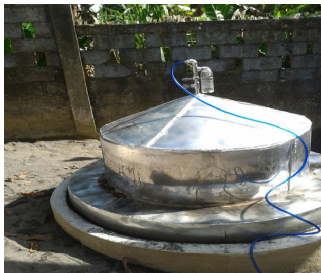
Colocación de tubería que conducirá el biogás.
