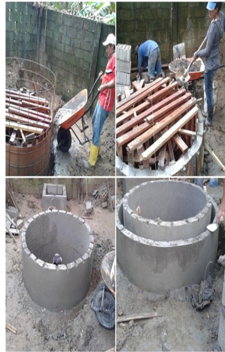
Fundición del Tanque o cámara de biodigestión.
