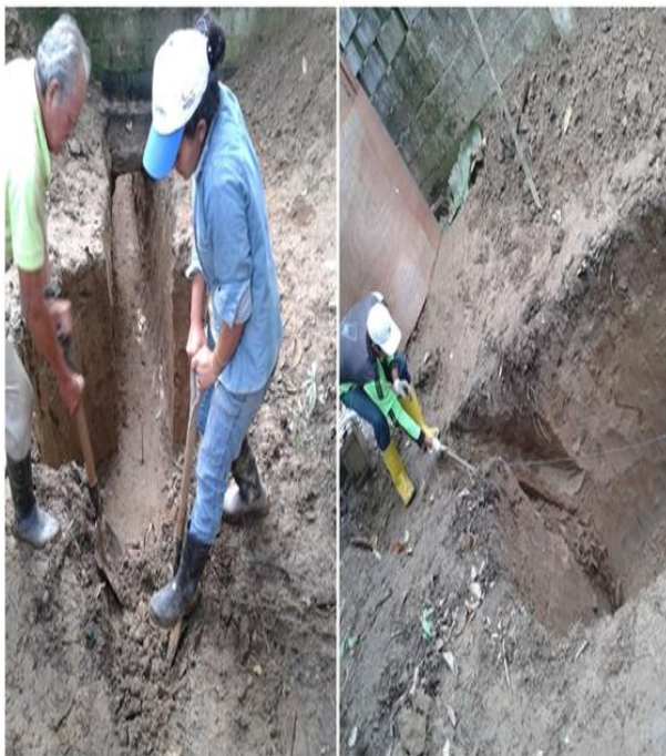
Excavación de la zanja de entrada.
