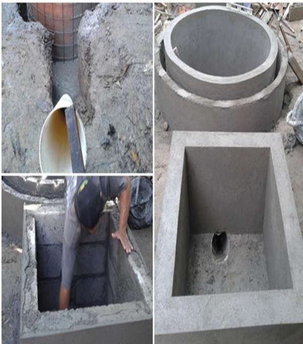
Construcción de la caja de entrada de estiércol.
