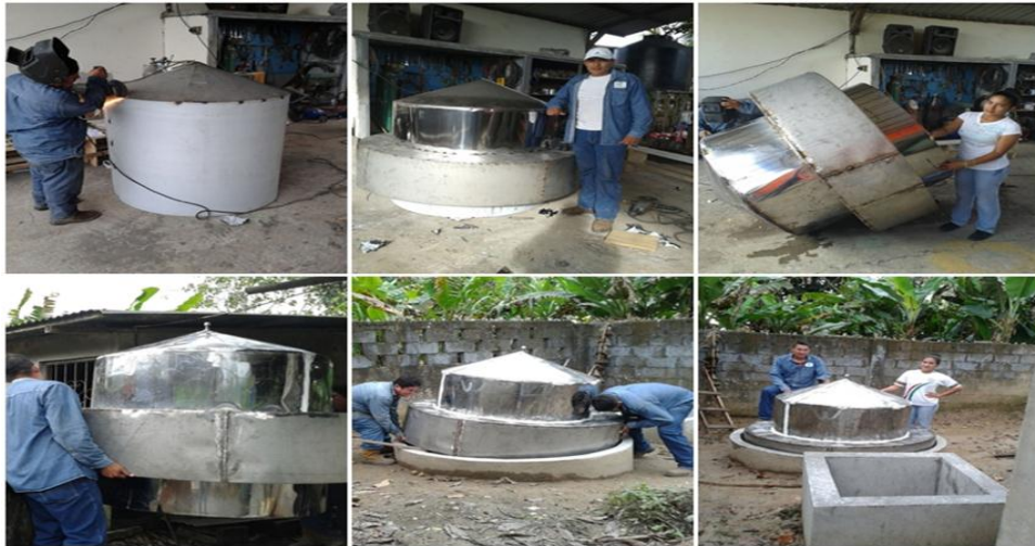
Construcción e instalación de la campana de acero inoxidable.
