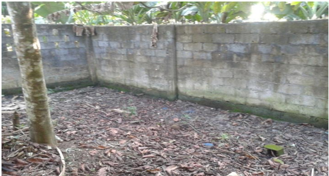
Área destinada para la construcción del biodigestor Hindú.
