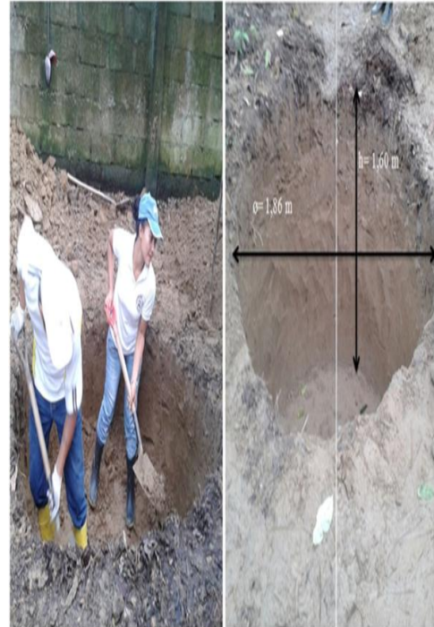
Excavación del hoyo para la construcción del tanque.
