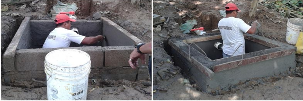
Construcción de la caja de salida de lodos.
