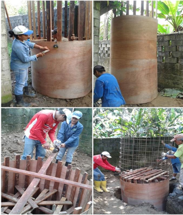
Construcción de la cámara de digestión del biodigestor.
